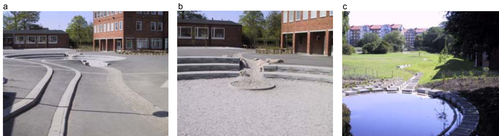
Figuur 3.2 Foto a en b zijn genomen op een schoolplein in Malmö (Zweden). De retentievoorziening heeft de vorm van een amfitheater en wordt ook gebruikt als ontmoetingsplaats voor leerlingen en openlucht colleges. Juist in de haarvaten van het watersysteem liggen kansen voor meervoudig ruimtegebruik. Foto c is genomen in de wijk Augustenborg in Malmö. Deze voormalige achterstandswijk heeft een kwaliteitsimpuls gekregen door watermaatregelen
