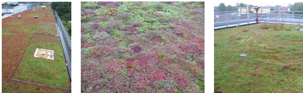
Figuur 3.3 Vegetatiedaken kunnen - afhankelijk van het type - 60 tot 100 % van het regenwater vasthouden. Vegetatiedaken van 3 cm dik kunnen op bestaande daken worden toegepast zonder dat hiervoor bouwkundige maatregelen moeten worden getroffen
