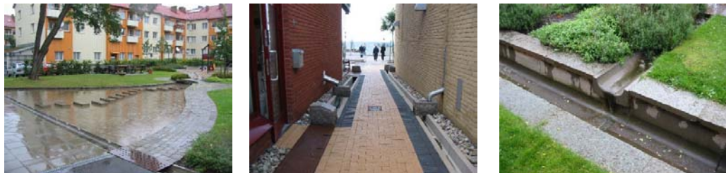
Figuur 3.4 Regenwater biedt meerwaarde aan de inrichting van publieke ruimte. Naast de esthetische waarde van oppervlakkige afvoer van regenwater, draagt het ook bij aan de beleving van water en de bewustwording bij bewoners. Bovendien worden foutieve aansluitingen hiermee voorkomen
