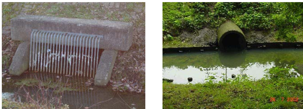
Figuur 2.4 Overstort en regenwateruitlaat op Hengelose beken
