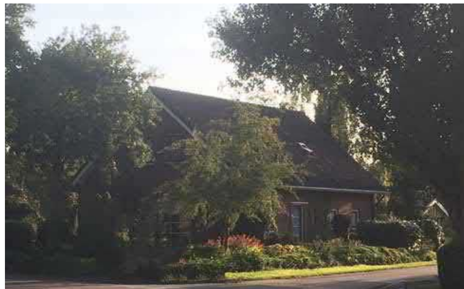
Afbeelding 25. Te slopen bebouwing aan de Bruninksweg
