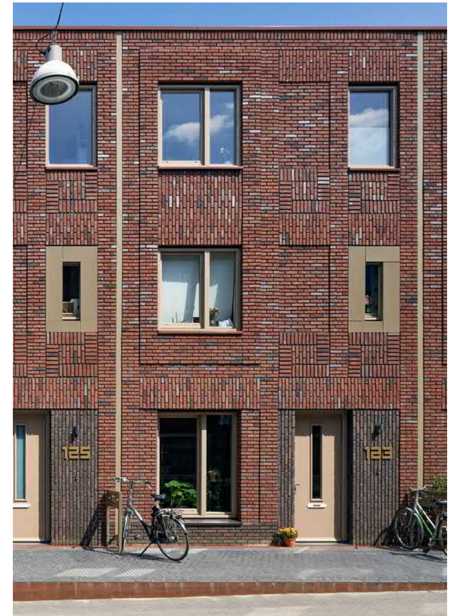
Afbeelding 9.0: Regenwaterafvoeren in gevelwand
