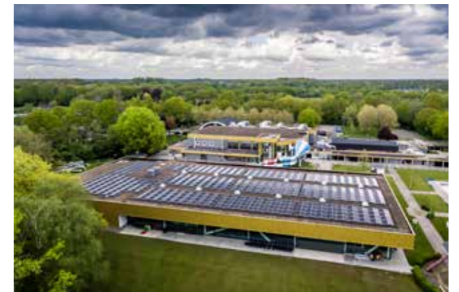
Zonnepanelen op het dak van het Twentebad (foto: Christian van der Meij)
