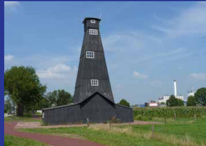
Overnachten in een oude zoutoren (Fotograaf: Willemjans Bron: nl.wikipedia.org/wiki/Bestand:Hengelo_Boortoren_16.jpg)
