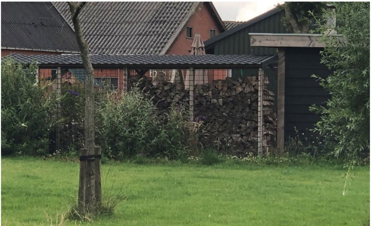
Afbeelding 3.5: Voorbeeld van goede vochtafvoer door open opslag waardoor de wind vrij spel heeft.
