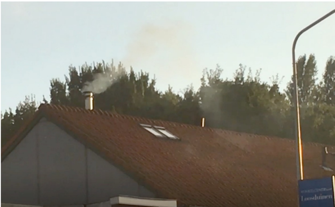
Afbeelding 8.15: Lijwerveffect waardoor de rookpluim omlaag wordt gezogen.
