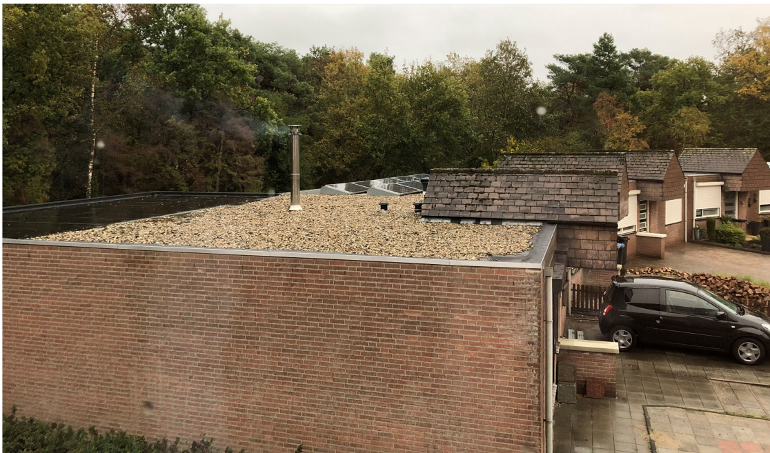
Afbeelding 12.3: Situering Helmond, schoorsteen gezien vanuit slaapkamer nabijgelegen woning
