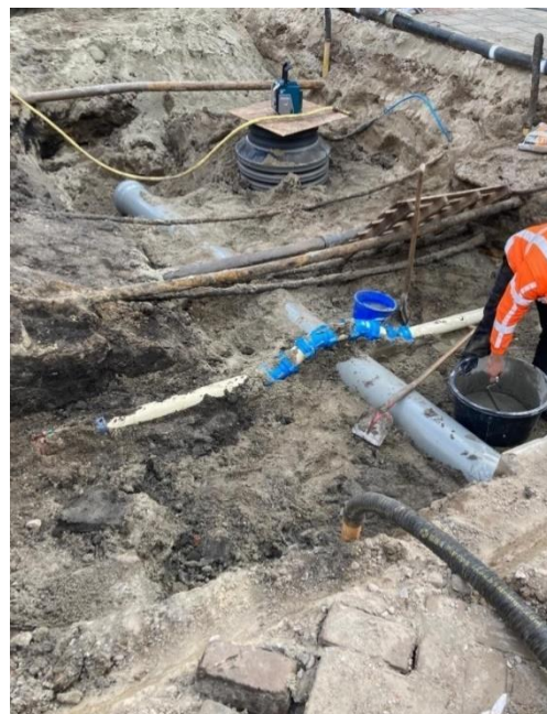
Figuur 7: Uitvoering rioleringswerkzaamheden
