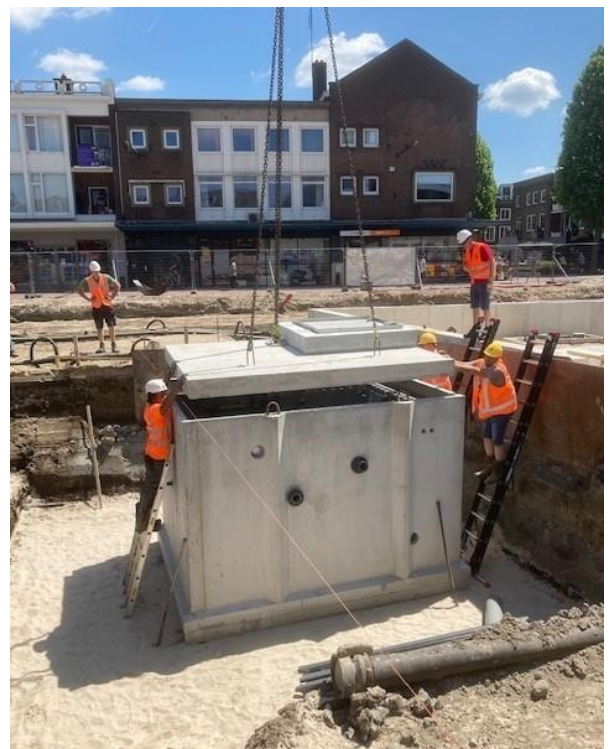
Figuur 9: Aanleg ondergrondse voorzieningen Markt/Brikstraat
