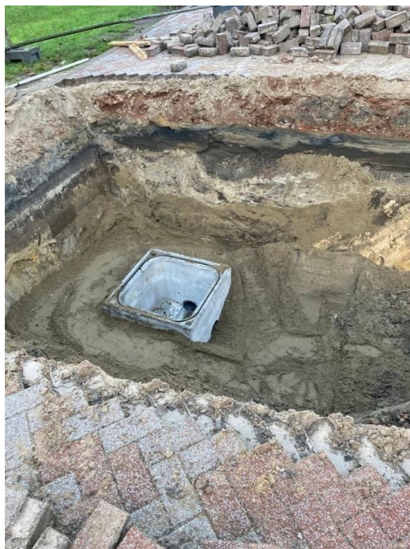
Figuur 17: Uitvoering rioleringswerkzaamheden
