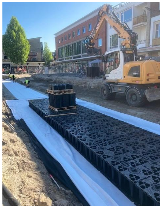
Figuur 5: Aanleg ondergrondse voorzieningen Markt/Brinkstraat
