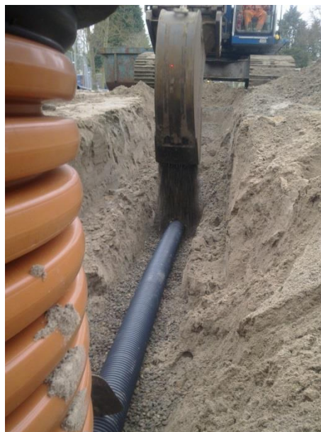
afbeelding 14: Aanleg drainage. Foto: Wareco
