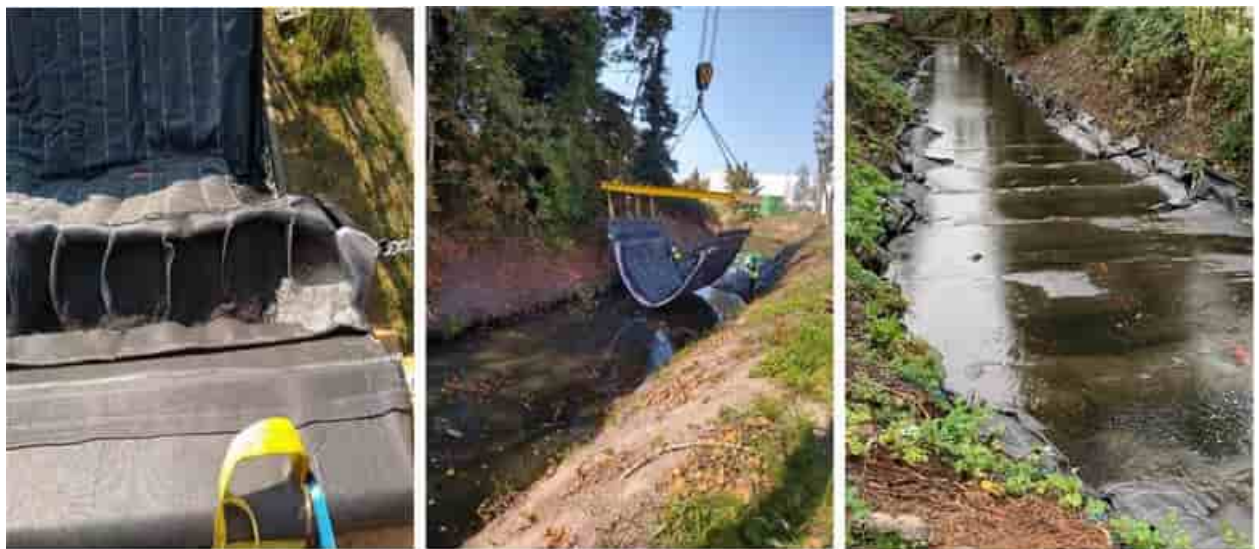
Figuur 3.21 Aanleg Natural Catch TAUW in Gent (bron: EU RESANAT)
