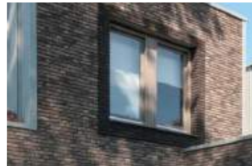
Grovere kozijnen in lichte ton-sur-ton kleur met gevel.
