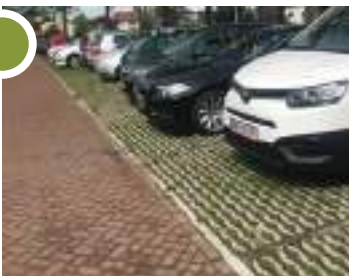
Parkeerplaats op open verharding
