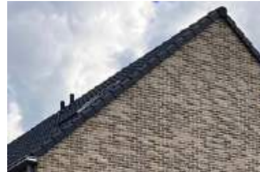
Dakrand is een slank onderdeel van de architectuur.
