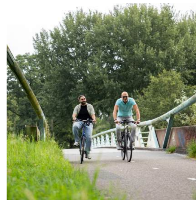
Fietsviaduct over A1
