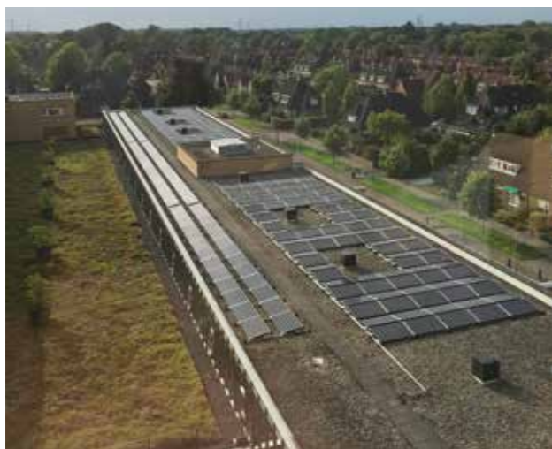
Zonnepanelen op het dak van Klokkstee van Zonnecollectief Tuindorp
