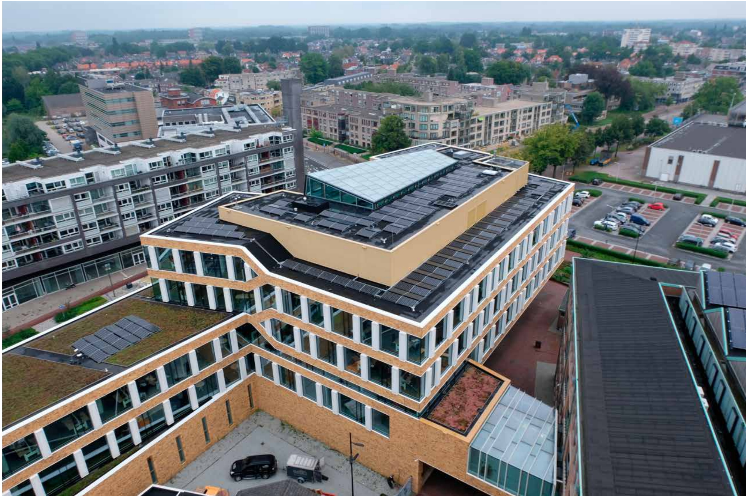
Zonnepanelen op het dak van het nieuwe stadhuis
