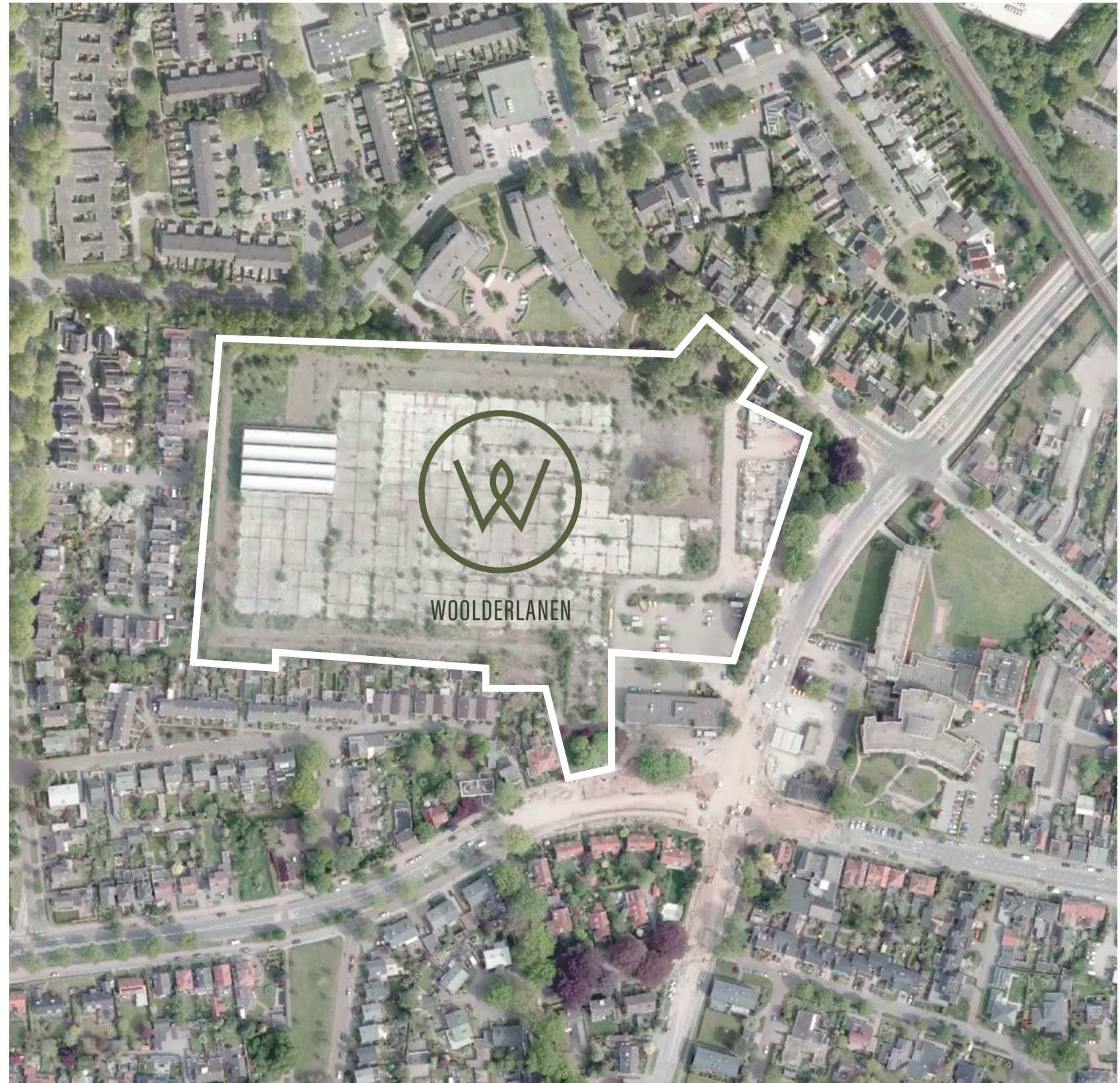
Luchtfoto huidige situatie
