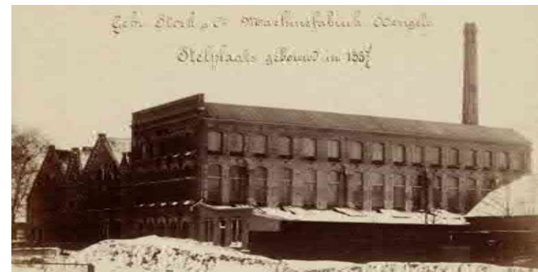
De stelplaats (1887) met rechts daarvan de zwem-badinrichting met badkamers. Het gebouw is nu onderdeel van gebouw 43 (43-D1). Bron: Collectie Overijssel, 23539 FDSTORK-A134-18.
