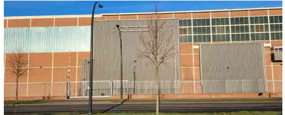
In de oostgevel is het verschil tussen de recent gevulde gevel en de reeds bestaande buitengevel goed zichtbaar
