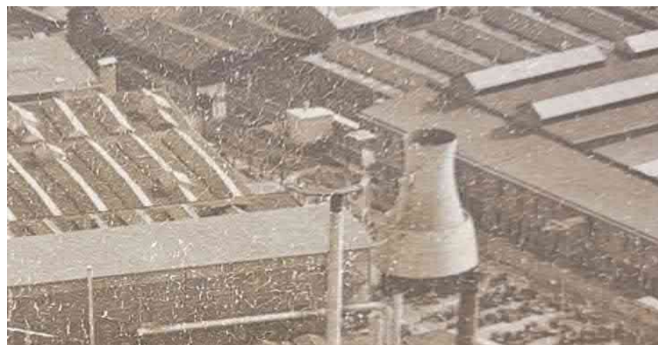
Opname tijdens de bouw van de tweede betonnen koeltoren. Bron: Collectie Gerard Lökber
