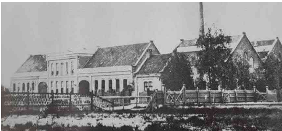
Foto van de fabriek gemaakt voor 1878. Het gebouw met de lijstgevel is het kantoor met rechts ervan het magazijn. Op de voorgrond de portierswoning (mogelijk het oude bleekhuisje). Bron: D.J.F. Wilmink, Hengelo in oude ansichten, Zaltbommel 1967, 103
