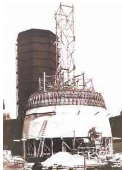
De bouw van de eerste betonnen koeltoren in 1952 met erachter de tweede nog houten koeltoren. Bron: Gemeente Hengelo
