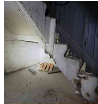
In het oudere gedeelte langs de fabrieksstraat is op de eerste verdieping een betonnen trap dichtgezet. De trap gaat nu van de eerste naar de tweede verdieping en niet meer van de begane grond naar de eerste. Dit is te zien aan de afgebroken staander en het doorlopende verwerk van de donker geschilderde lambrisering op de foto rechts. Op de begane grond is de weggehakte trap nog in het muurwerk zichtbaar.
