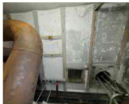
Het troggewelf in de centrale
