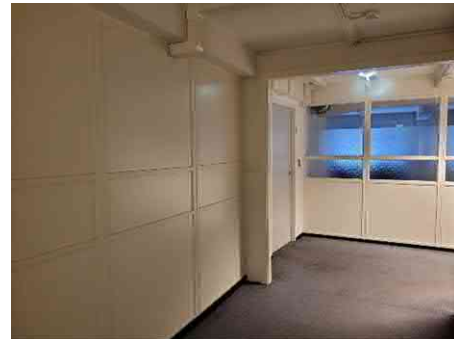
Latere aangebrachte tussenwanden om verschillende ruimtes te creëren
