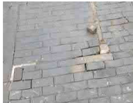
Detail van de houten bestrating in gedeelte E
