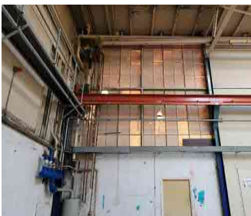
In de westgevel van hal B zijn de vensters nog zichtbaar
