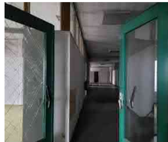
De gang op de vierde verdieping met een plafond van zachtboard de originele tussenwanden achter voorzetwanden en een deurklink gelijk als de deurklink van de entree van Industrieplein 2
