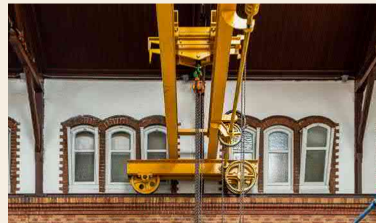
4.1.7. Detail uit het monumentale Ketelhuis
