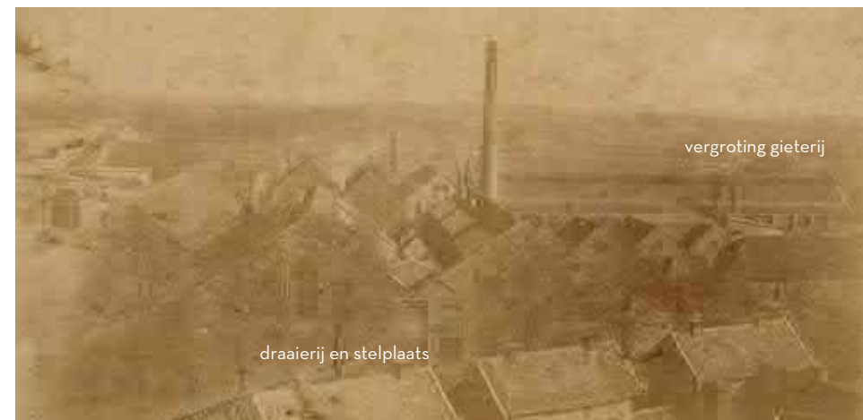
Het terrein in 1886. De draaierij en stelplaats zijn vanaf zijkant zichtbaar. Rechts daarachter de gieterij met zijkapellen die vergroot is. Het magazijn links op de foto is eveneens vergroot. Bron: Collectie Overijssel 23537 FDSTORK-A134-15
