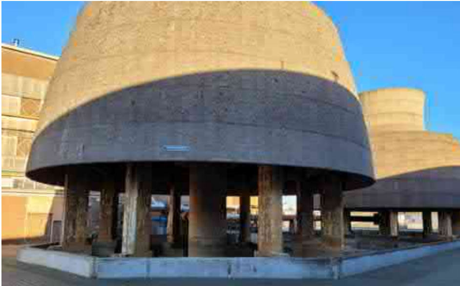
De torens vanuit het westen
