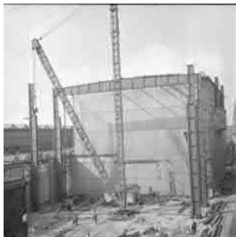
Foto tijdens de bouw van het tweede gedeelte van de Overweghal. De tussenwand tussen het eerste en tweede gedeelte is goed zichtbaar. Bron: Collectie Overijssel 27027 FDSTORK-11165
