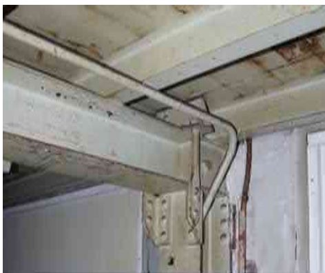
Detail van de staalconstructie van gebouw 45E. Foto: R. Stenvert
