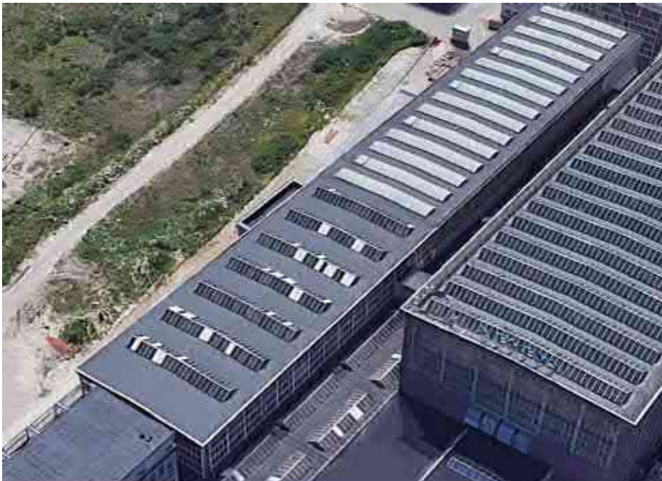
De westgevel. Bron: Google Earth
