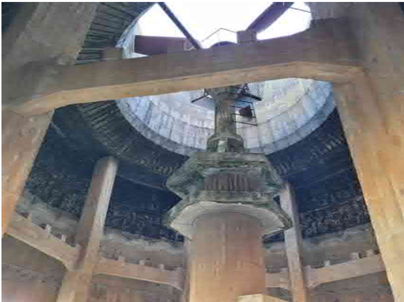
De oostelijke koeltoren
