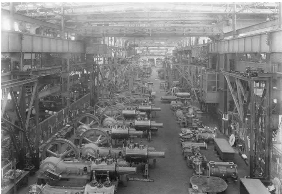
De stelplaats van Stork in 1927 met kraanbanen in de middenhal en etagevloeren in de zijbeuken. Bron: Collectie Overijssel, 8725 FDSTORK-5365
