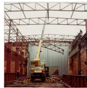
Op deze foto van het herstel na de brand in 1978 is links op de foto de behouden constructie van D1 te zien. Bron: Collectie Overijssel, 22766 FDSTORK-A281-26
