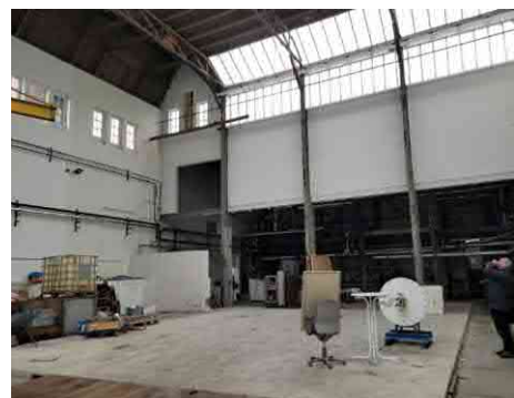
Interieur en constructie van het ketelhuis (gedeelte B)
