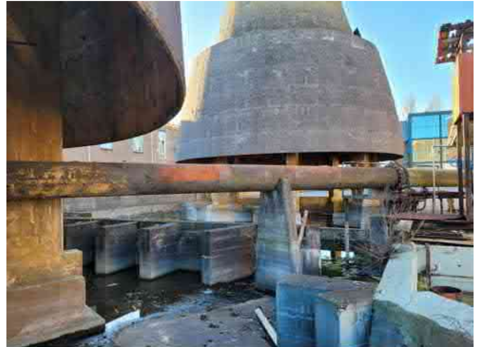
Detail van de toevoerleiding en het bassin tussen de torens in
