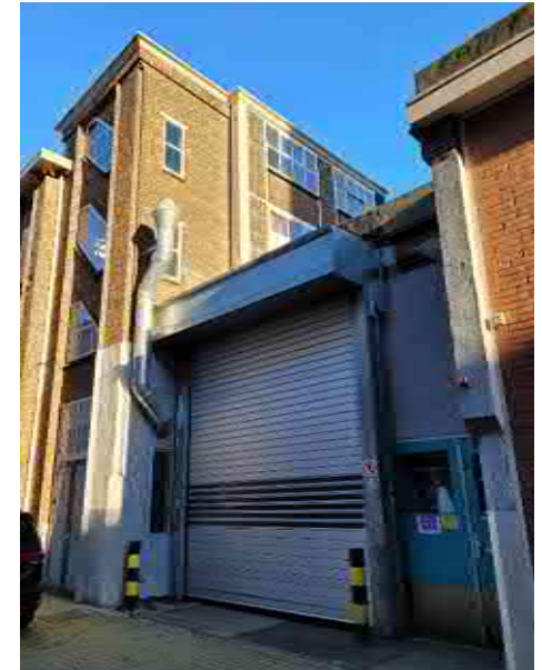
De zuidgevel van gebouw 45
