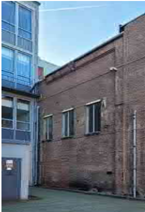
De noordgevel van 45C (links), 45D en 45E
