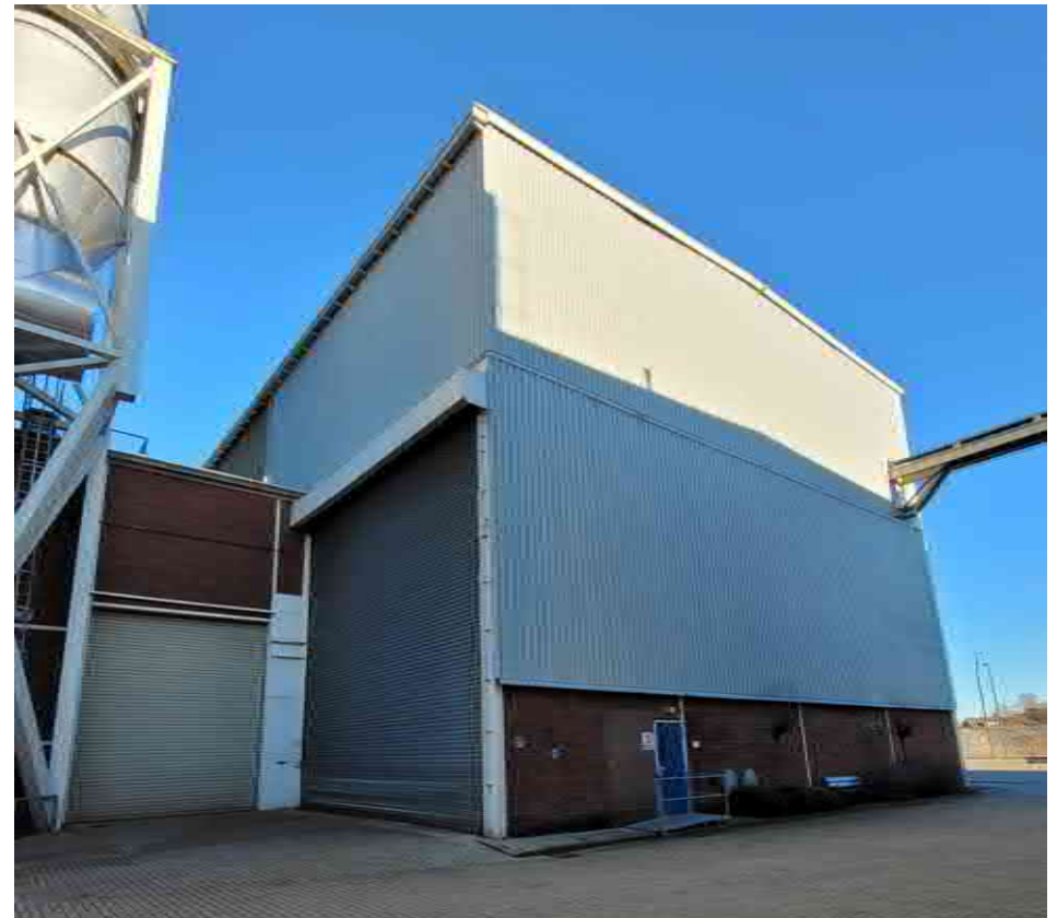
De zuidgevel en een gedeelte van de westgevel
