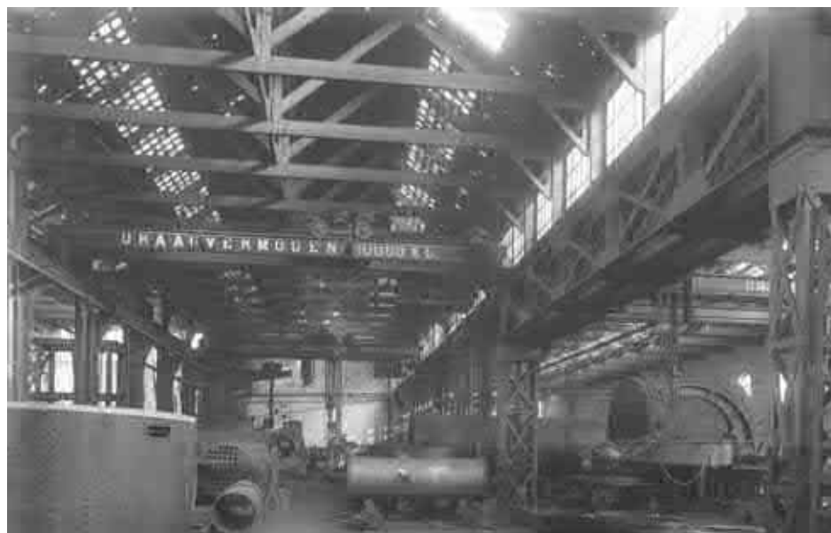
Hal 45A in 1908, dan nog onderdeel van de ketelmakerij. Links achterin zijn de drie vensters van 45B te zien en bij de linker kolommen de gietijzeren consoles. Bron: Collectie Overijssel, 2594 FDSTORK-5516
