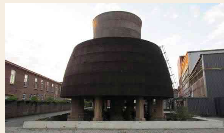
4.1.8. Een van de twee koeltorens op het zuidelijk deel van de locatie
