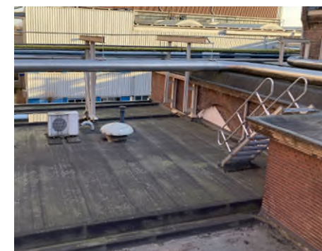
In de noordgevel is op het dak nog een gedeelte van de zijmuur van het magazijn uit 1912 te zien. Bron: Trebbe
