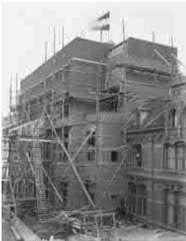
De bouw van het nieuwe kantoor in 1928. Bron: Collectie Overijssel, 21935 FDSTORK-6671
