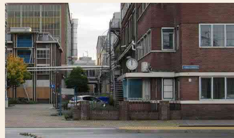
4.1.9. Noordelijke entree richting de Fabrieksstraat met kenmerkende portiersloge als onderdeel van het Dienstgebouw
