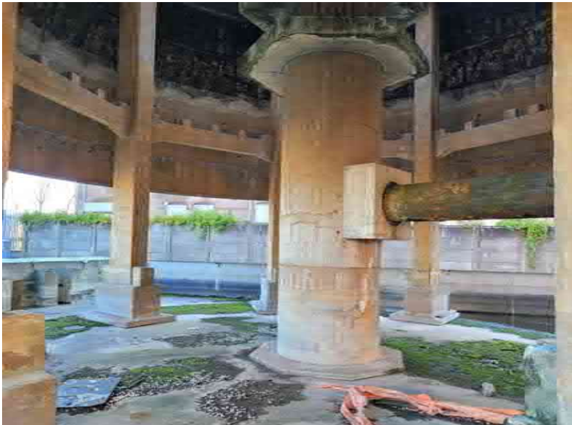
De oostelijke koeltoren
