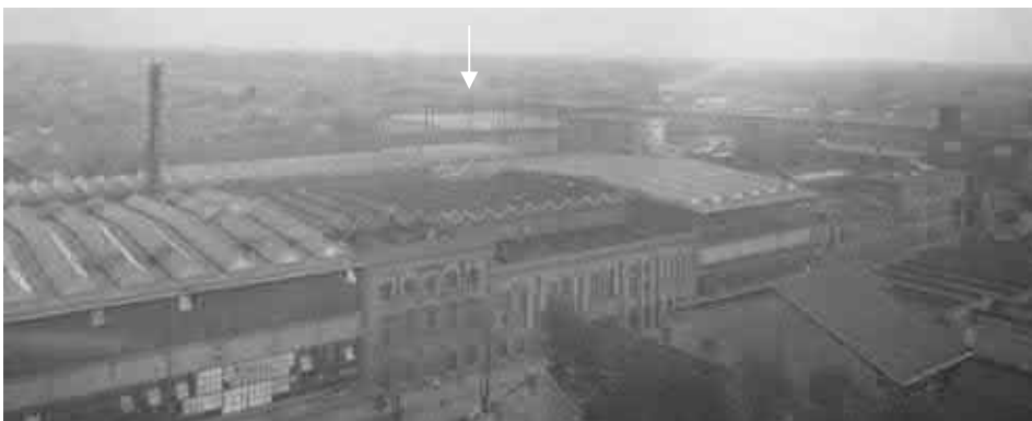
Op deze foto uit 1913 is op de achtergrond de staalconstructie van gebouw 50 in opbouw zichtbaar. Bron: Collectie Overijssel, 10491 FDSORK-6483
