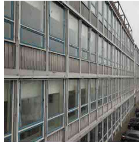
Detail van de oostgevel
