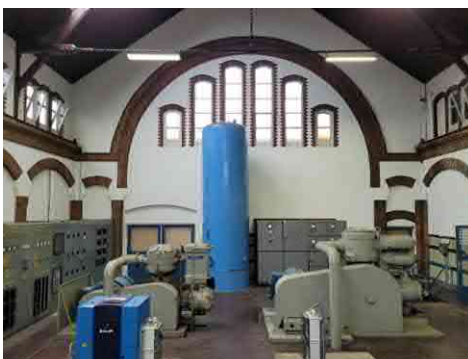
De centrale uit 1901 (naar het oosten)
