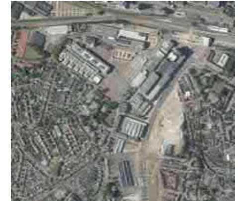
Het terrein in 2019. Hier is het ROC gereed, de fabriek van Hijsch een staalskelet. Bron: luchtfototijdreis.nl
