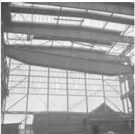
Foto tijdens de bouw van het eerste gedeelte de Overweghal. Bron: Collectie Overijssel 33579 FDSTORK-11150
