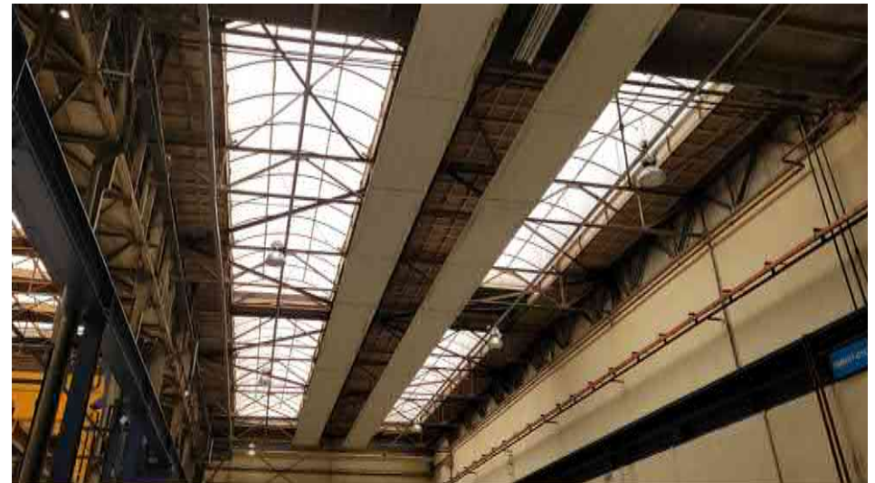
Overgang van het houten dak naar het cassettendak met lichtstraat in dwarsrichting
