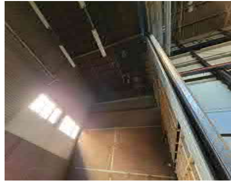
De aanbouw vooraan hal D
