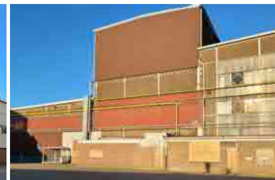
Detail van de zuidgevel met bij hal C goed zichtbaar de vensters met ruitvormige roedeverdeling
