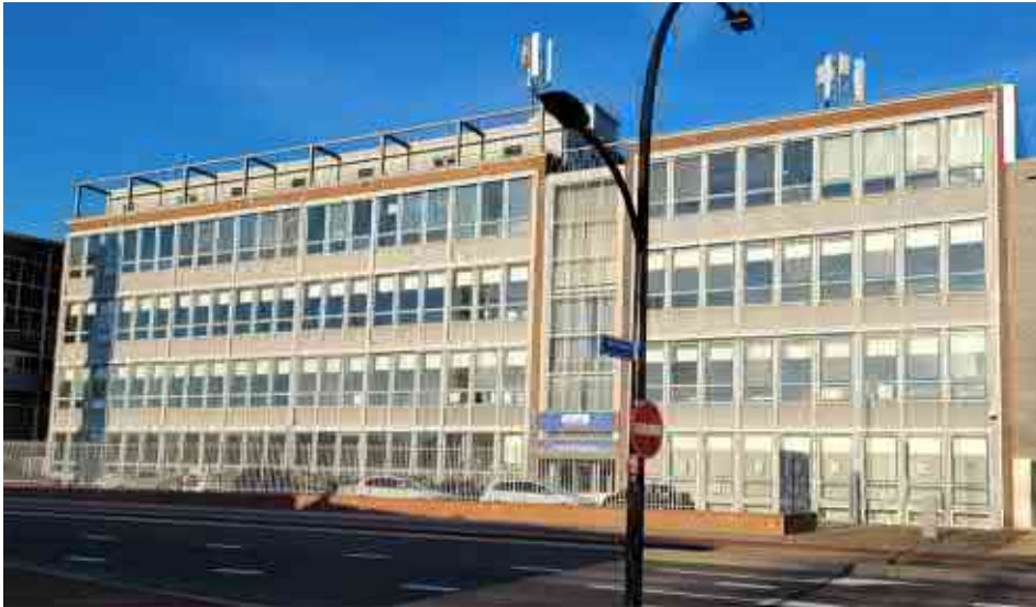
De oostgevel van gebouw 3 en 4
