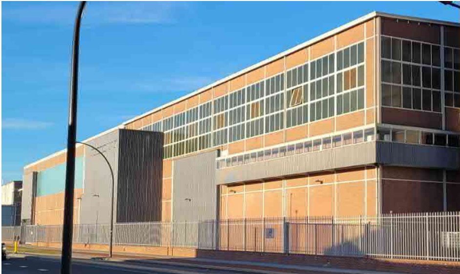
De oostgevel als gevolg van de inkorting en een gedeelte van de noordgevel
