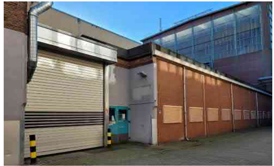
De westgevel van 45D met boven het grijs geschilderde pleisterwerk nog ouder metselwerk in kruisverband
