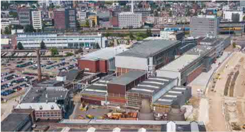
Luchtfoto vanuit het zuiden. Bron: Trebbe
