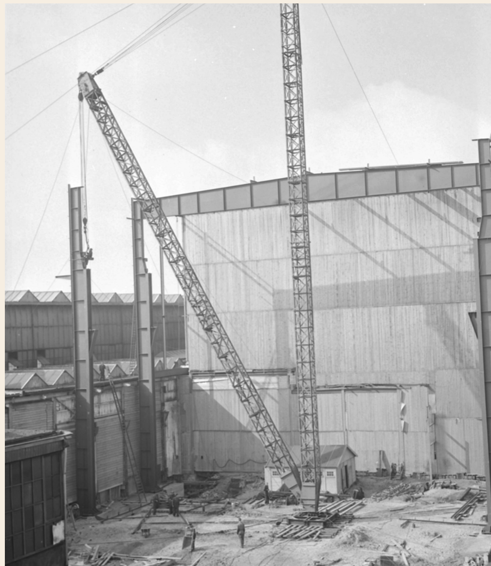
5.2.1. Bouw van de Overweghal, aangehecht aan de naastgelegen Ketelmakerij en Ossenhall
