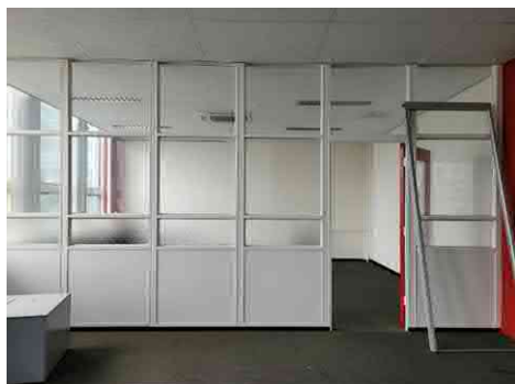
Tussenwand op de tweede verdieping van gebouw 3 > niet op de plattegrond uit 1999
