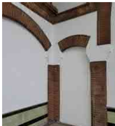
Betegelde wand, terrazzo vloer en siermetselwerk in de centrale
