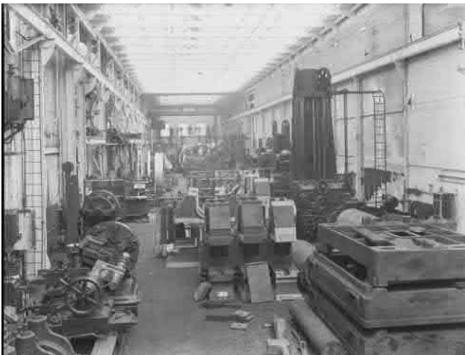
Foto van hal 45B 'de oude mijnschachtenafdeling' volgens het onderschrift rond 1926. De hal is goed herkenbaar aan de drie vensters in de achterwand en aan de constructie met gietijzeren consoles en onderspannen liggers aan de linkerzijde. Bron: Collectie Overijssel, 2650 FDSTORK-6039
