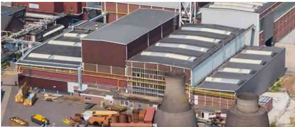
De zuidgevel van gebouw 21. Bron: Trebbe
