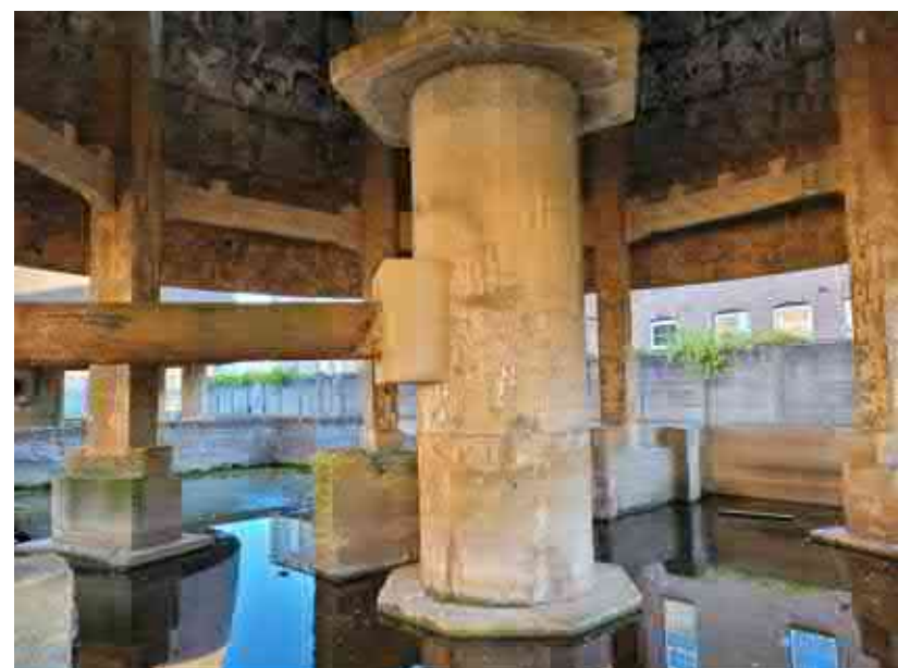
De westelijke toren
