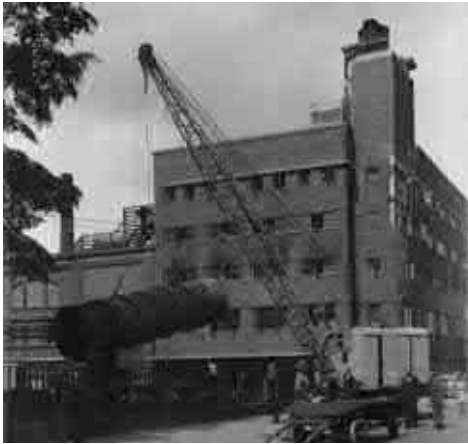
Het dienstengebouw in juni 1945 als de Canadezen de tijdelijke schuilkelders demonteren. Op deze foto is de nog niet herstelde oorlogsschade goed zichtbaar. Ook is te zien dat het gebouw hier nog niet boven het voormalige magazijn aan de fabrieksstraat doorliep. Bron: Collectie Overijssel, 8782 FDSTORK-6362
