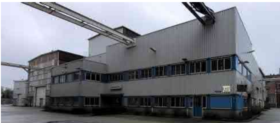
De noordgevel van gebouw 21
