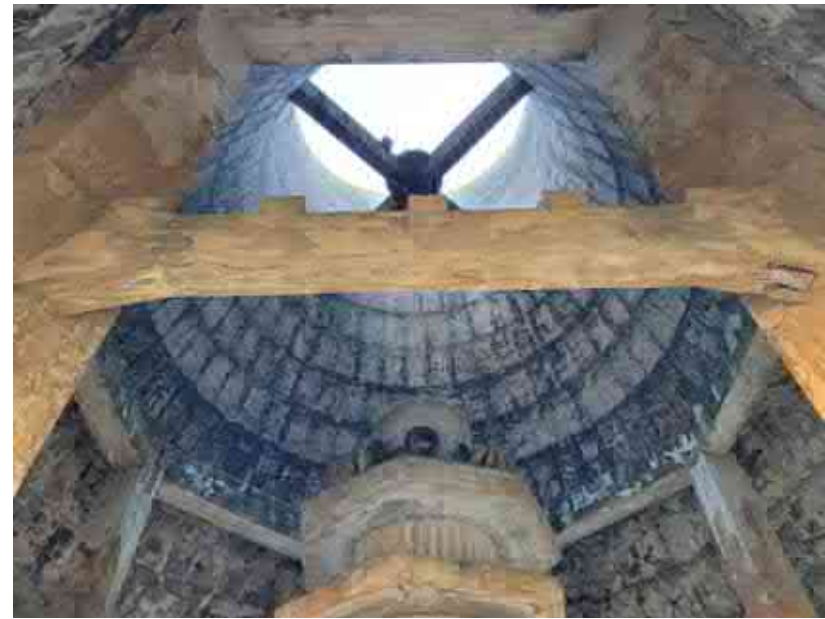
De westelijke toren
