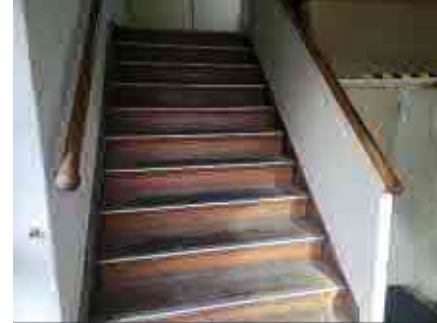
Een houten trap in het opgehoogde gedeelte aan de fabrieksstraat op de vierde verdieping met nog de oude afwerking.
