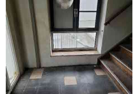
Het bordes van dezelfde trap met in de vensterbank de oorspronkelijke tegels en op de vloer colovinyl uit de jaren vijftig
