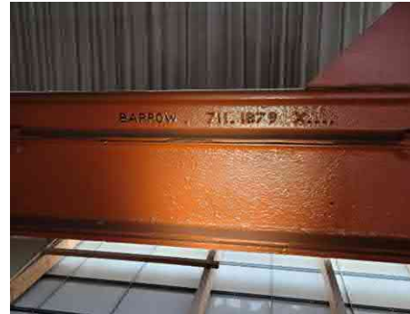
Detail van een ligger in gedeelte A
