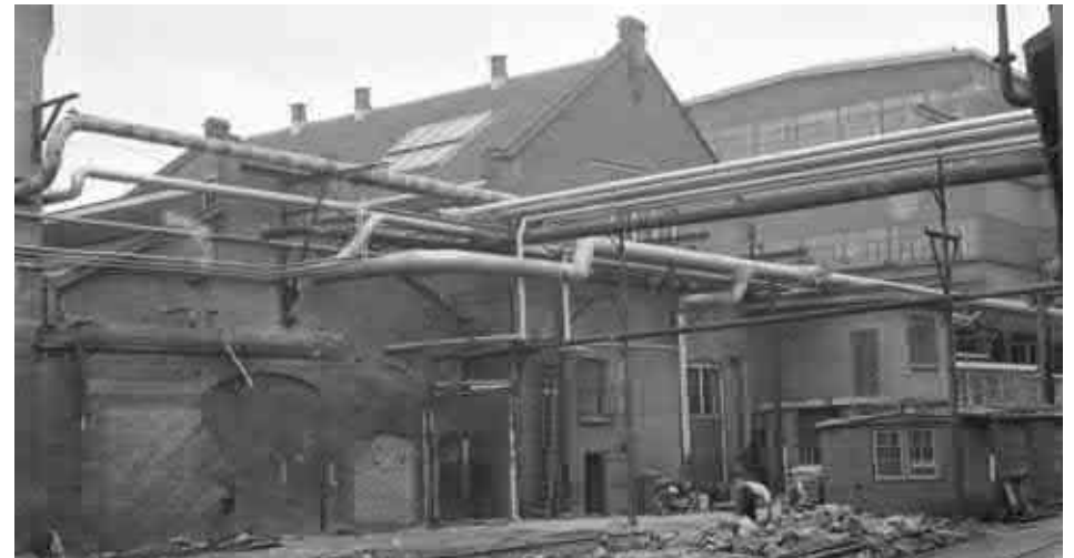
Op deze foto uit 1957 is te zien dat het ketelhuis nog iets is afgetopt (links) en dat rechts van de centrale uitgebouwd is. Bron: Collectie Overijssel, 27946 FDSTORK-112360
