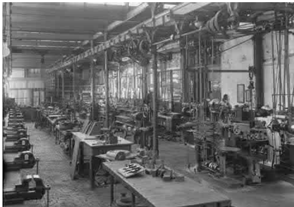
Op deze foto is de gereedschapmakerij rond 1922 te zien. Deze bevond zich op de locatie van de huidige hal 45D. Op deze foto zijn nog gietijzeren kolommen te zien. Bron: Collectie Overijssel, 9877 FDSTORK-5930
