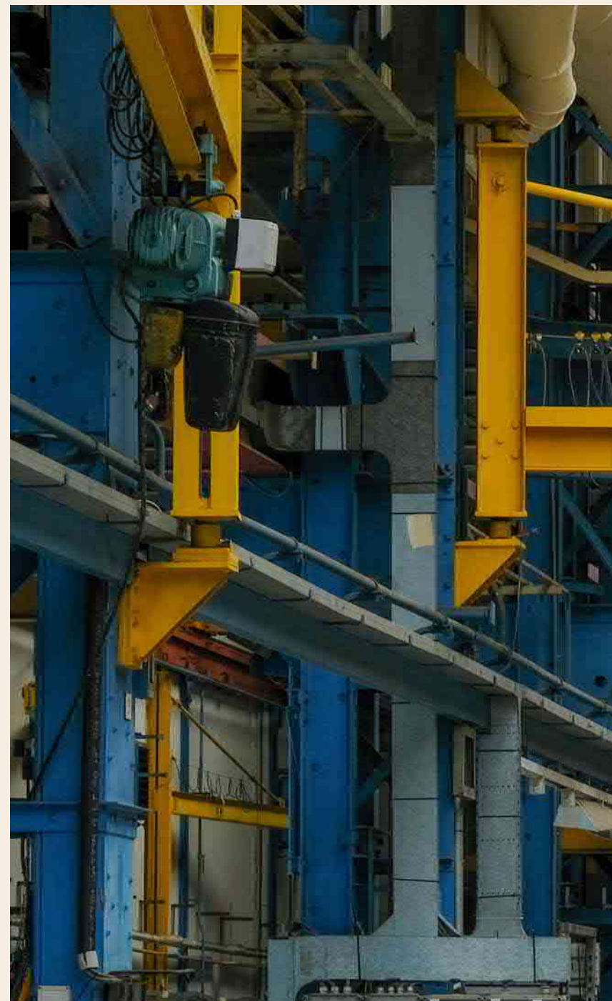
3.5.9. Kenmerken- de gele kranen in Grote Stelplaats
