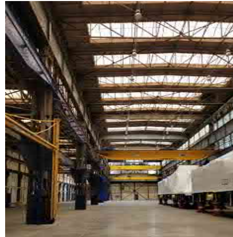
De hoge beuk vanuit het zuiden. Ongeveer ten hoogte van de eerste loopkraan gaat de constructie van het dak over van N-liggers in vollewandliggers. Bij de kolom links is een gele kolomzwenkkrana zichtbaar.
