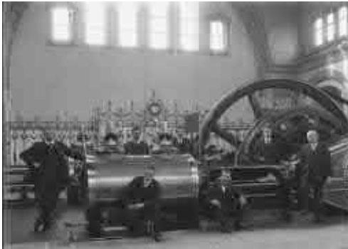
Het ketelhuis in 1908. Bron: Collectie Overijssel, 2588 FDSTORK-5510Diversen.
