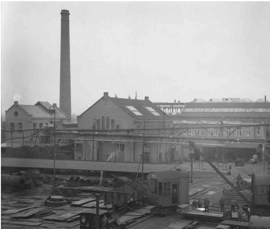
De centrale met ketelhuis in maart 1913. De smalle werkplaats ten noorden van de centrale is al gebouwd, de wasinrichting nog niet. Bron: Collectie Overijssel, 2098 FDSTORK-6488
