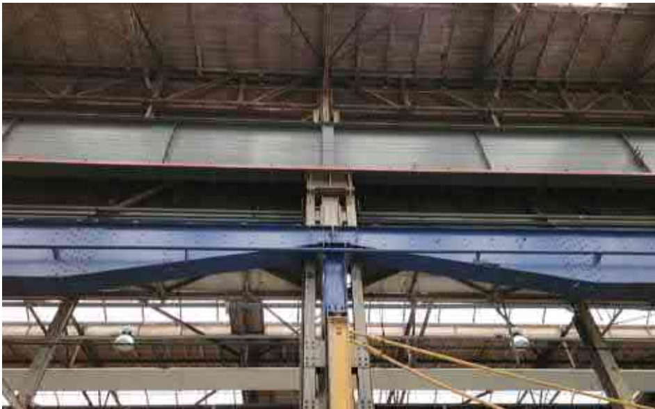
Boven elkaar de geklonken en gelaste vollewandligger met erboven de N-liggers voor het dak en de houten constructie van dit deel van het dak
