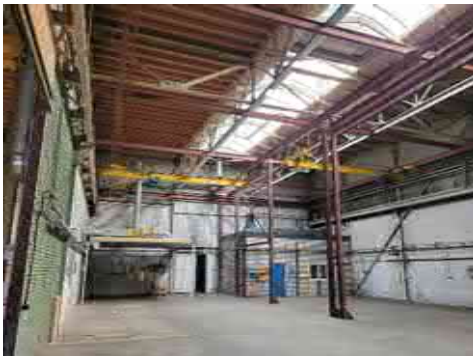
Hal F met in het rood de constructie voor de loopkraan
