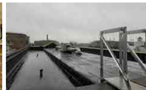
Het dak van de opbouw aan de zuidoostzijde
