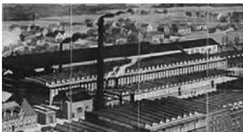
In 1912 is het dak verhoogd en vervangen voor een zadeldak met lichtstraten. Bron: Collectie Overijssel, 2120 FDSTORK-6507
