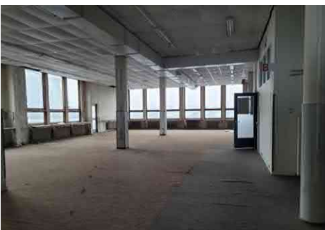
Ruimte op de derde verdieping van gebouw 3
