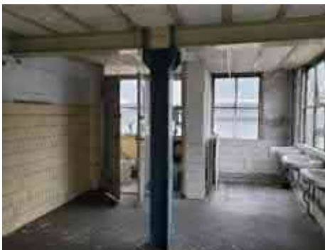
De wasruimte met toiletten op de eerste verdieping van 45E
