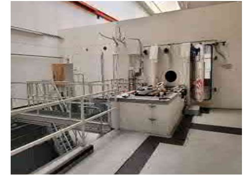
De achterzijde van de balanceerbunker
