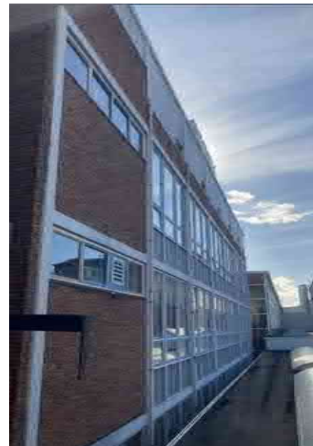
De westgevel van gebouw 4. Bron: Trebbe
