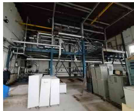
Interieur en constructie van het ketelhuis (gedeelte C)
