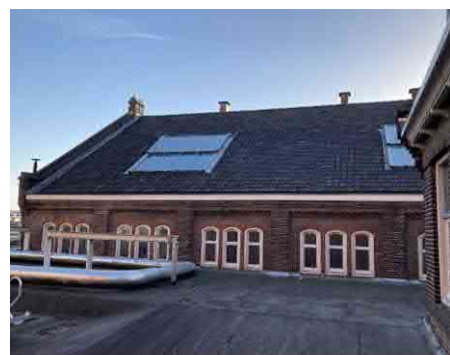
De noordgevel van de centrale. Bron: Trebbe
