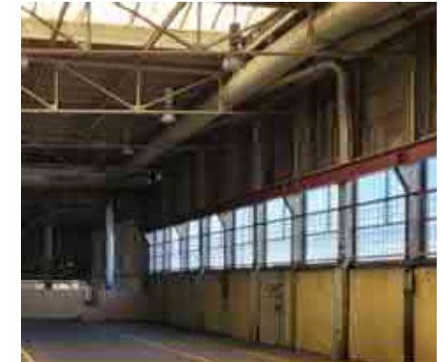
De geklonken consoles in de zijgevel van gedeelte C (westzijde, tweede verdieping)
