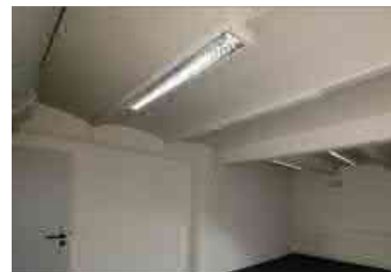
In ruimte 5.0.01 is als enige een constructie met betonnen troggewelfjes aangetroffen
