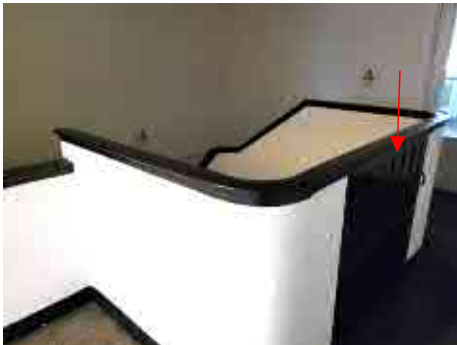
Een van de weghaalbare delen van de balustrade van de trap
