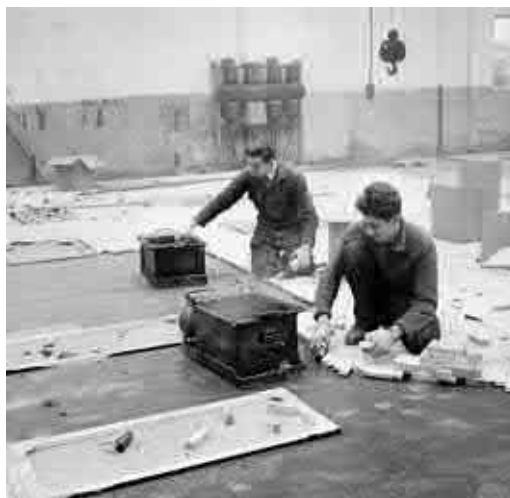
Het leggen van een kopshouten vloer in de nieuwe gereedschapafdeling. Bron: Collectie Overijssel, 1957HCO01-FDSTORK-10919
