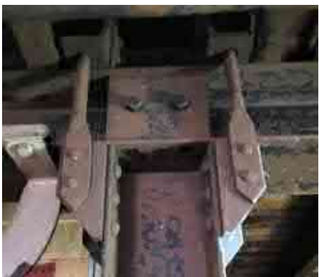
Detail van de staalconstructie van gebouw 45E
