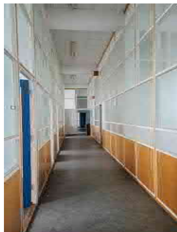
Gang op de derde verdieping van gebouw 4 met oorspronkelijke tussenwanden
