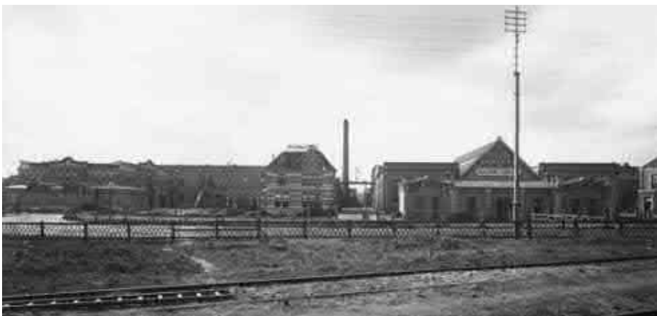
Zicht op de fabriek rond 1898. In het midden is het nieuwe kantoorgebouw uit 1894 zichtbaar (links van de schoorsteen) en naast het magazijn (rechts met de naam van de fabriek op de gevel) is de uitbouw zichtbaar op de plek van de oude portierswoning. Bron: Collectie Overijssel, 9923 FDSTORK-6444
