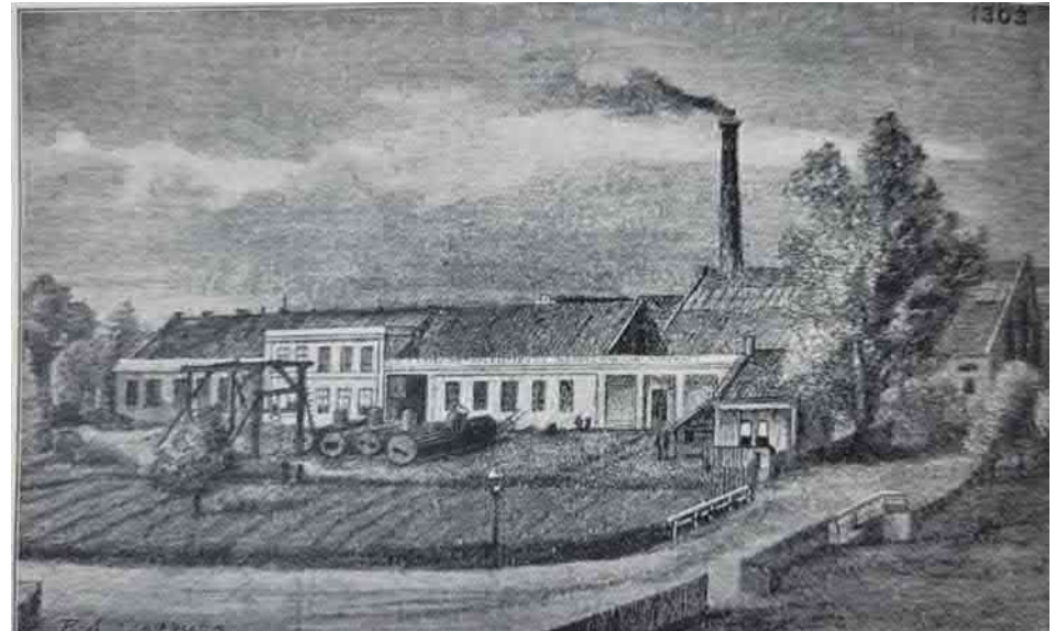
Tekening van de fabriek in 1878. Bron: Machinefabriek Gebr. Stork & Co Hengelo, opgericht 1868., Hengelo 1922
