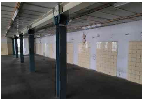
De eerste verdieping van 45E met betegelde zones op de wand en brandwerende isolatie tussen de liggers van de verdiepingvloer
