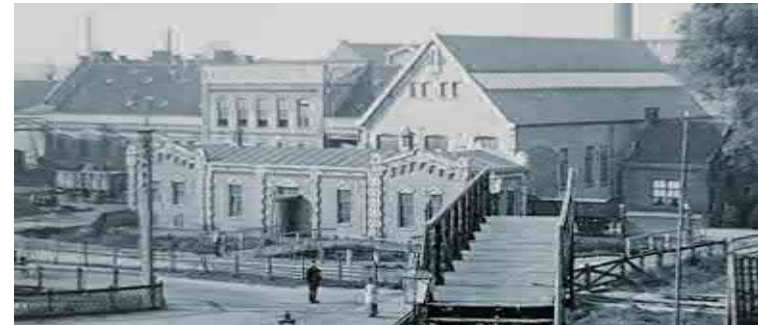
De voorzijde in 1893. Het magazijn uit 1878 is het grote pand met zadeldak. De portierswoning staat ernaast. Het gebouw vooraan is de bergplaats van de coöperatieve winkelvereniging. Bron: Löbker e.a. 2018
