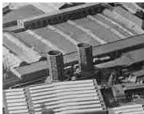
De twee ronde houten koeltorens rond 1940. Bron: Collectie Overijssel, 7661 fd stork 6299
