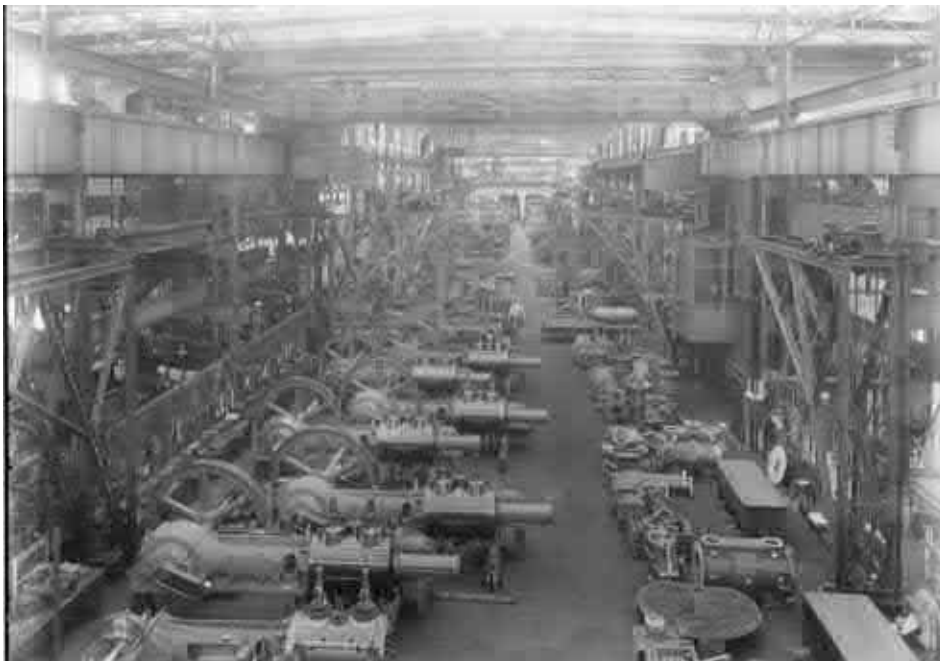
Interieur van de stelplaats in 1927. De foto is genomen in gedeelte C, de geklonken vollwandliggers zijn aan weerszijden zichtbaar. Erachter rechts zijn de N-liggers van gedeelte D1 te zien en daarachter de oude constructie van D2. Bron: Collectie Overijssel, 8725 FDSTORK-5365
