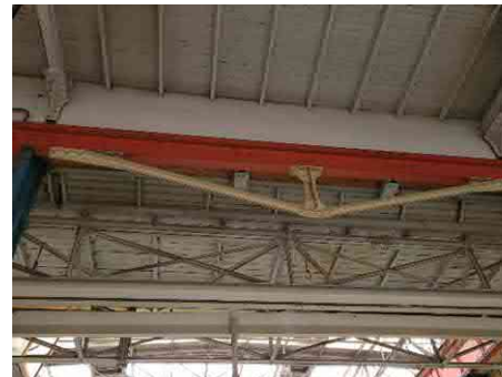
De deels geklonken overspannen balk in de tweede travée van gedeelte B met onder de ligger die het dak draagt een ijzeren console
