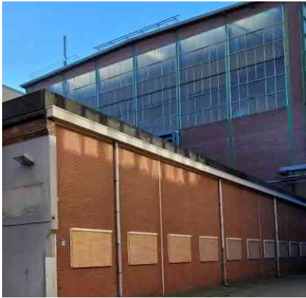
De noordgevel van gebouw 50
