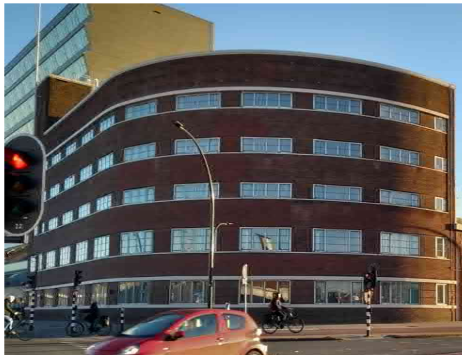
De gebogen gevel van gebouw 5
