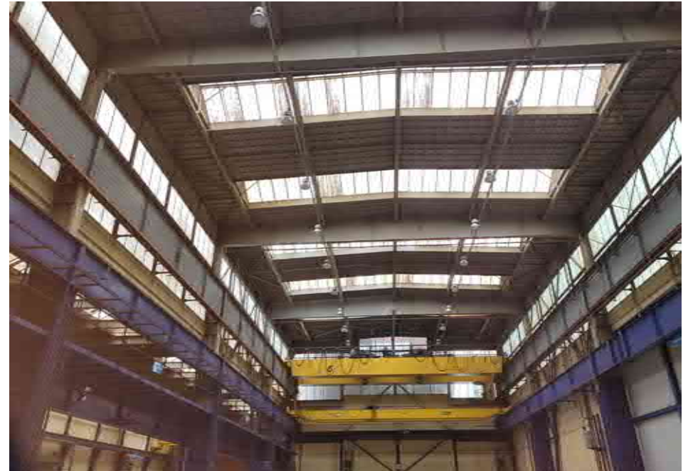
De uitbouw uit 1968 heeft vollewandliggers in het dak en voor beide kraanbanen en in het plafond bimsbeton cassettenplaten
