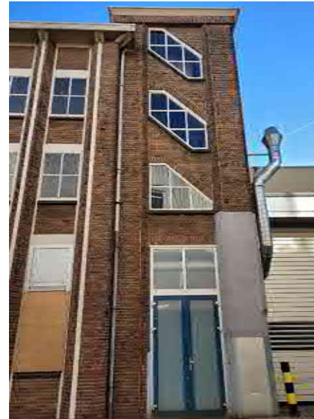
Detail van de westgevel van 45E
