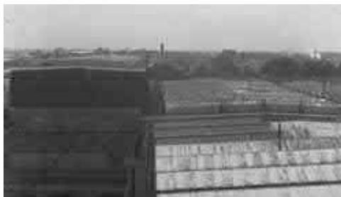
De zuidoostzijde van de hal in 1930. Bron: Collectie Overijssel 4888 FDSORK-6163
