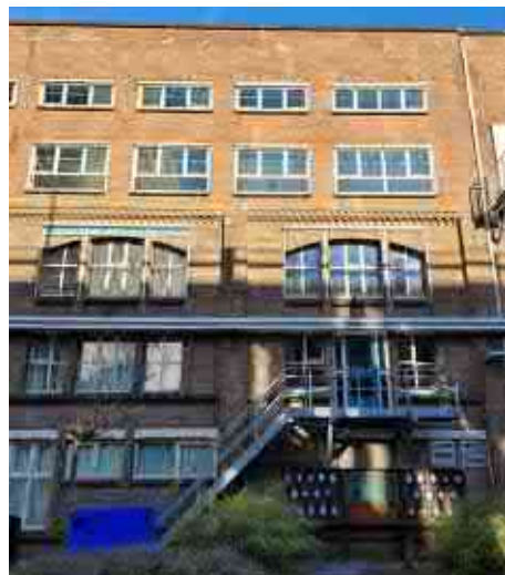
Detail van de westgevel met een nieuwer deel op de oudere bouw
