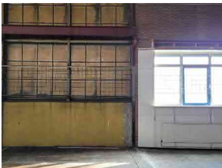
Overgang tussen C en D3 in de oostgevel
