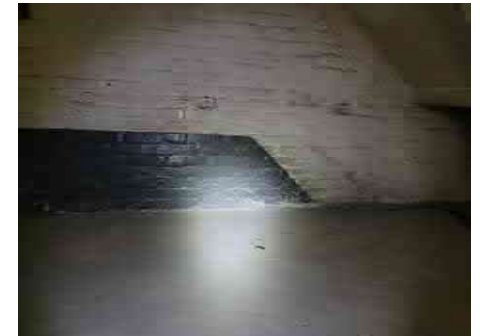
In het oudere gedeelte langs de fabrieksstraat is op de eerste verdieping een betonnen trap dichtgezet. De trap gaat nu van de eerste naar de tweede verdieping en niet meer van de begane grond naar de eerste. Dit is te zien aan de afgebroken staander en het doorlopende verwerk van de donker geschilderde lambrisering op de foto rechts. Op de begane grond is de weggehakte trap nog in het muurwerk zichtbaar.
