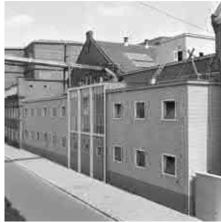
De westgevel in 1959. De gevel is vernieuwd en opgehoogd, de muur is vervangen en het achterliggende dak is vervangen voor een hoger plat dak. Bron: Collectie Overijssel, 30070 FDSTORK-11386
