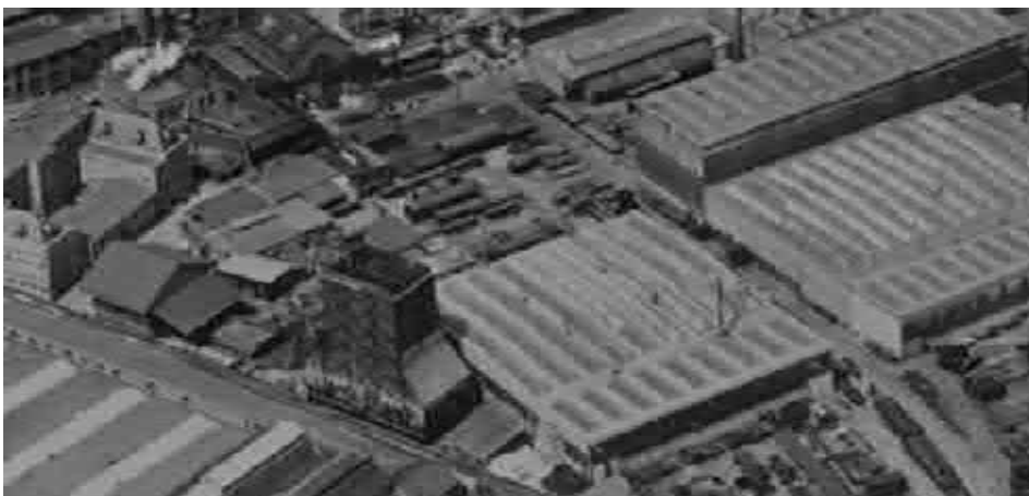
Op deze foto uit 1922 is de pijpenbuigerij zichtbaar en het braakliggende terrein tussen de pijpenbuigerij en de centrale. Bron: Collectie Overijssel, 2624 FDSTORK-6015
