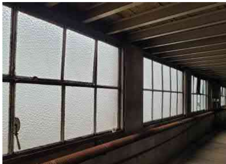
Detail van de vensters in 45E
