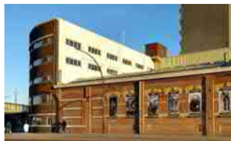
Tegen de zuidgevel en de westgevel van de opbouw zijn damwanden geplaatst.
