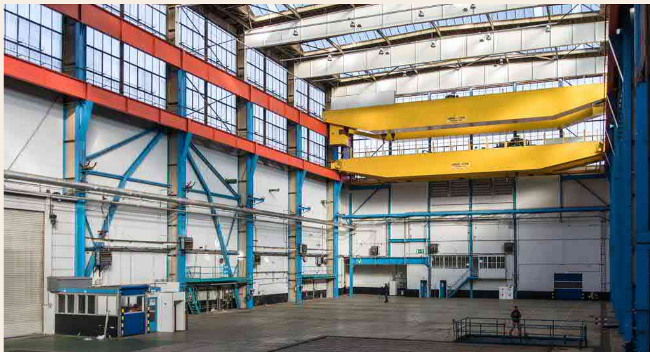
4.1.11. Interieur van de Overweghal met een hoogte van circa 27 meter
