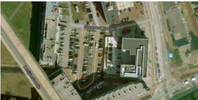
Luchtfoto Plegt-Vos gebouw
