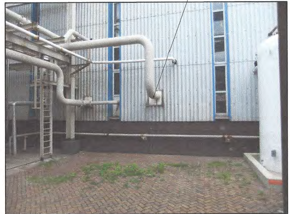
Foto beoogde locatie pomp nabij EF-gebouw
