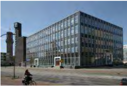
Straatbeeld Plegt-Vos gebouw
