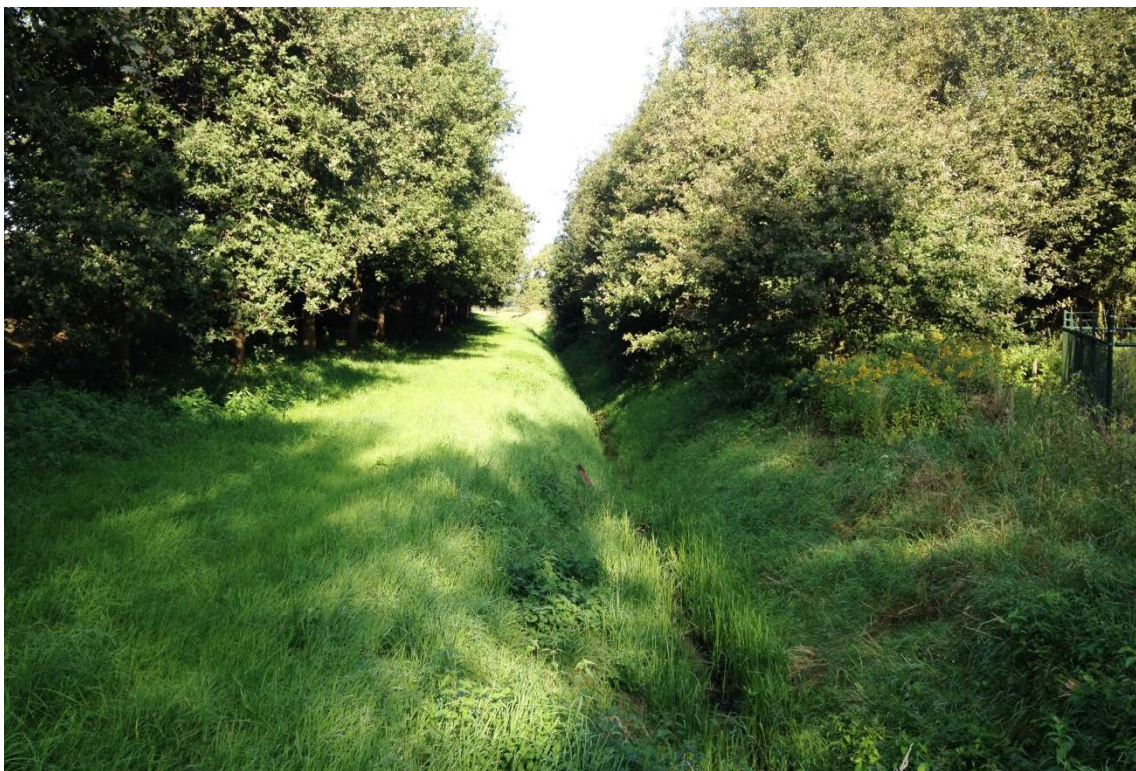
Schouwpad westzijde Houtmaatbrug
