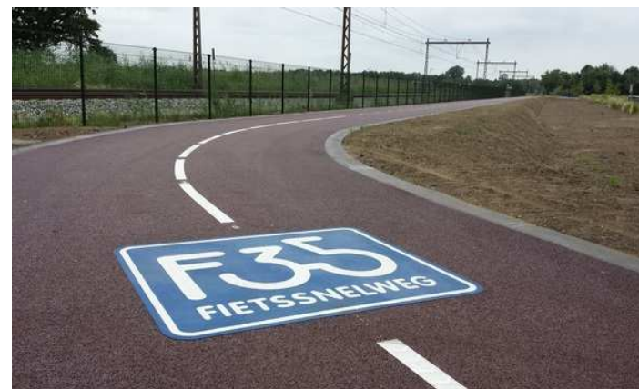
Gerealiseerde Fietssnelweg F35; Westermaatsfietspad (kijkend richting Borne)
