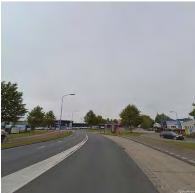
Verder Vosboerweg in, hier wordt tweede strook linksaf aangelegd (gezien vanaf Bornsestraat)
