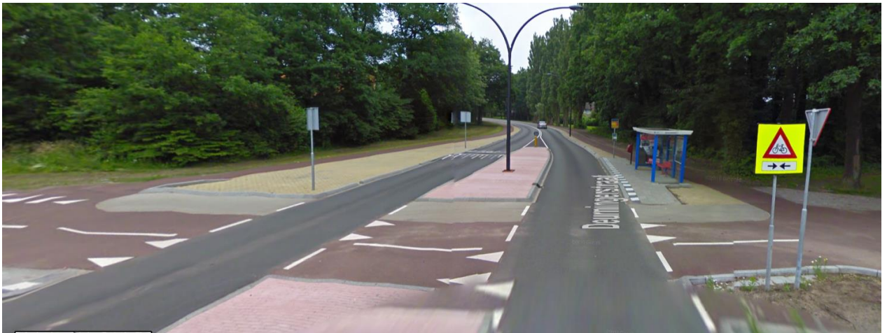
Figuur 4: Bebording kruising Roeshoekpad met Deurningerstraat van dichtbij.
