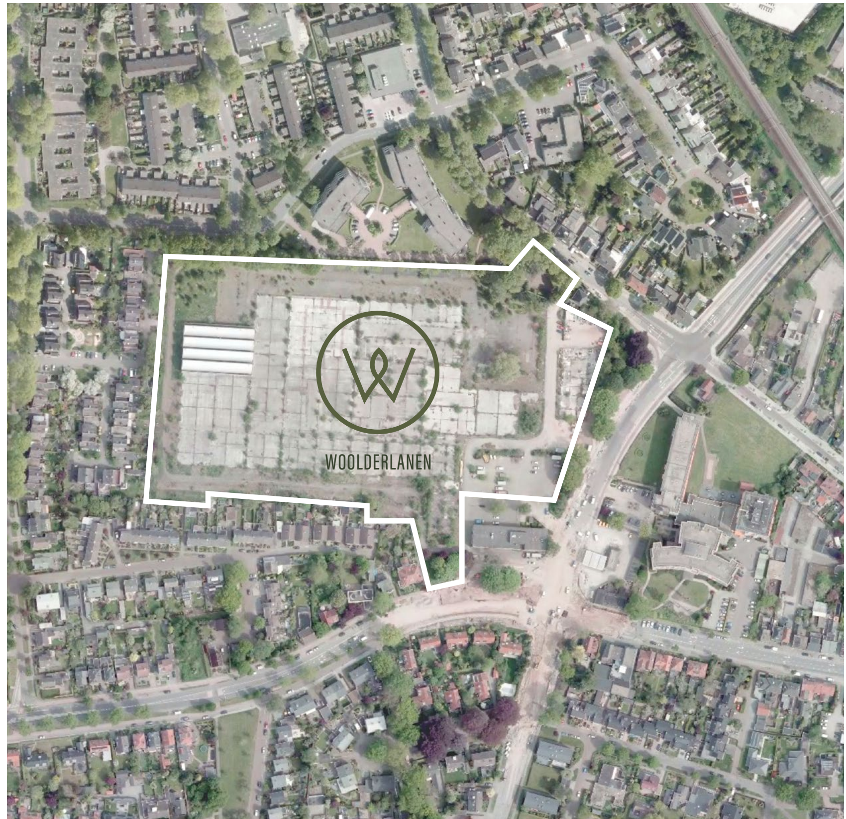
Luchtfoto huidige situatie
