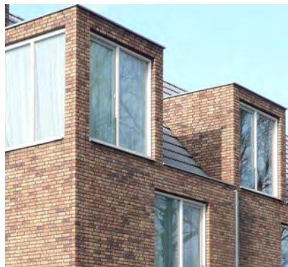
principe van doorgemetselde dakkapel
