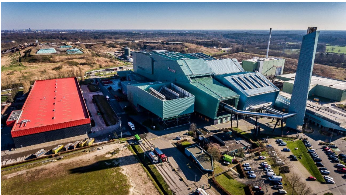
Figuur 3-Afvalverwerkingscentrale Twence Boeldershoek
