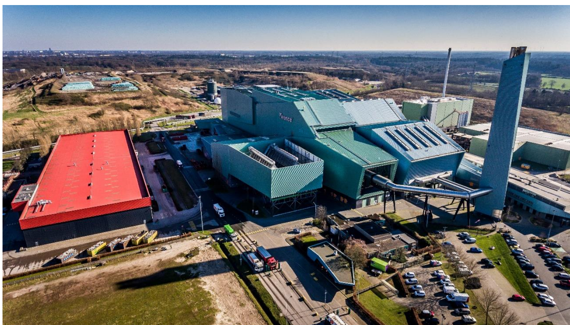
Figuur 3-Afvalverwerkingscentrale Twence Boeldershoek
