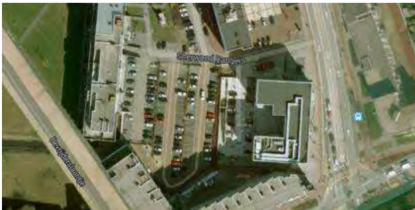
Luchtfoto Plegt-Vos gebouw
