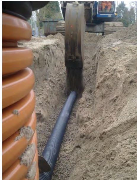
afbeelding 14: Aanleg drainage. Foto: Wareco
