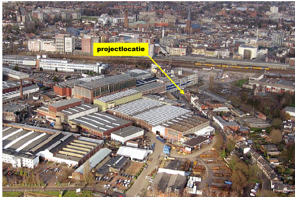
Luchtfoto met aanduiding projectlocatie Bron: gemeente Hengelo
