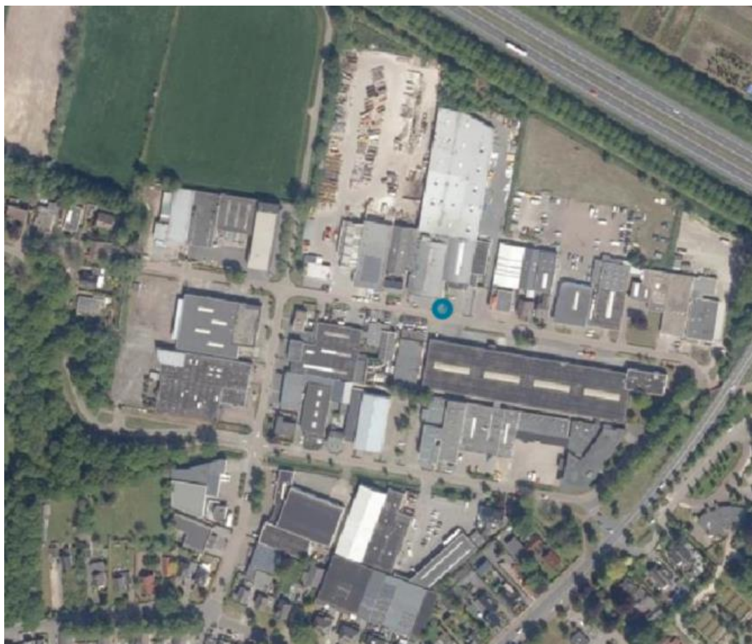
Luchtfoto Bedrijventerrein Timmersveld
