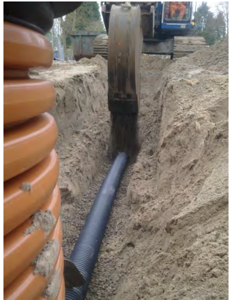
afbeelding 14: Aanleg drainage. Foto: Wareco
