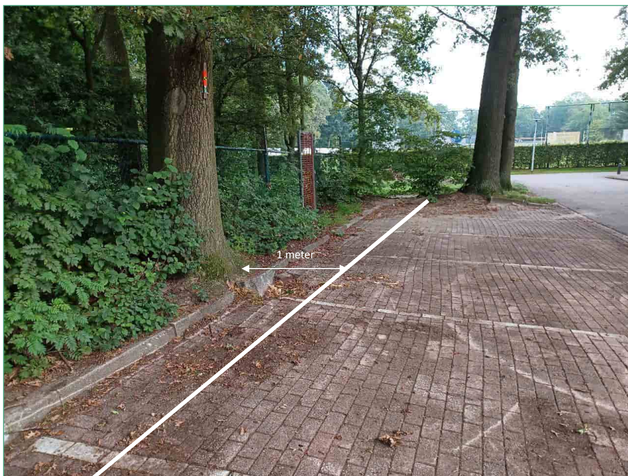
Afbeelding 4.14 bestrating opdruk door te klein gedimensioneerde boomspiegel.
