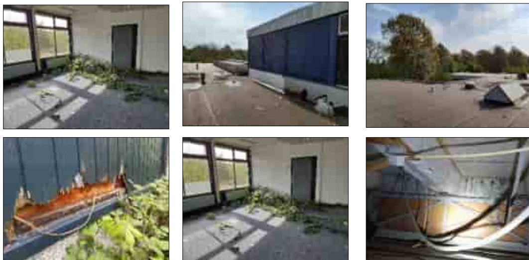
Afbeelding 4.6: Foto's van Sportlaan Driene 8, gevonden kieren en gaten die mogelijk geschikt zijn voor vleermuizen en andere vogels en de ruimte tussen het dak en de dakpanelen.
