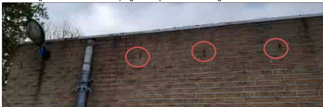
Afbeelding 4.5: Foto van de stootvoegen bij P.C. Hooftlaan 15, deze zijn geschikt voor vleermuizen (rood omcirkeld)
