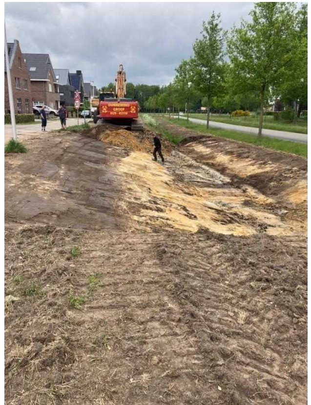
Figuur 14: Aanleg bovengrondse watervoorziening
