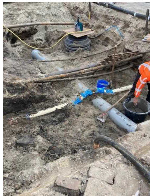
Figuur 7: Uitvoering rioleringswerkzaamheden
