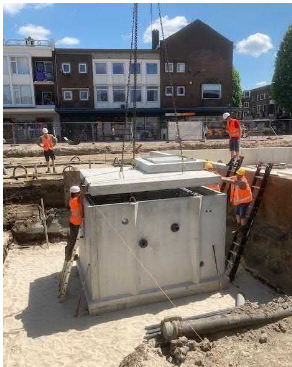
Figuur 9: Aanleg ondergrondse voorzieningen Markt/Brikstraat
