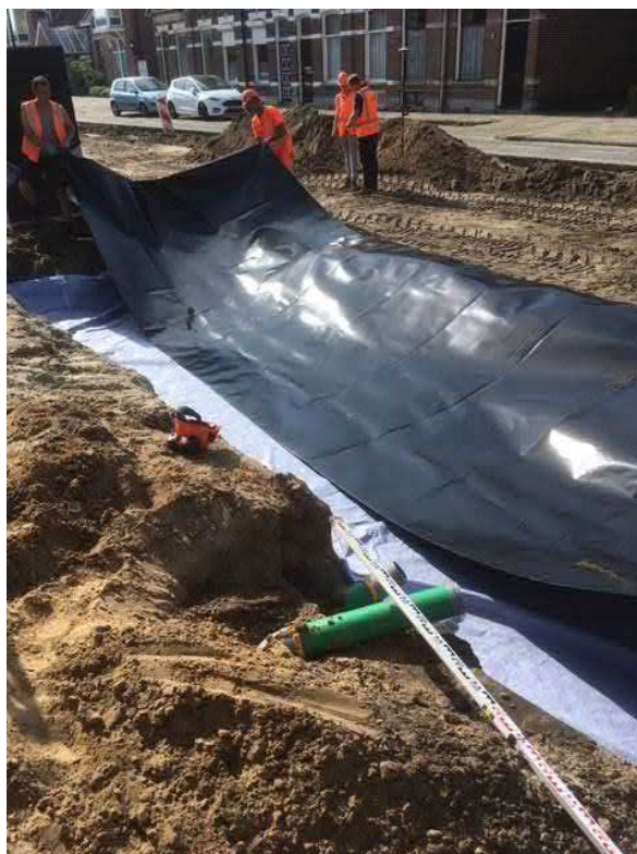
Figuur 1: Aanleg waterberging bij rioolreconstructiewerkzaamheden Deldenstraat
