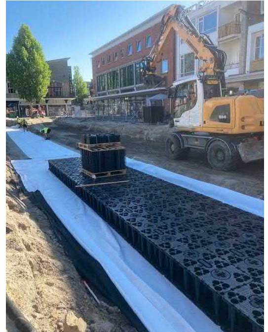
Figuur 5: Aanleg ondergrondse voorzieningen Markt/Brinkstraat
