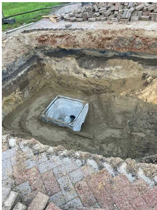
Figuur 17: Uitvoering rioleringswerkzaamheden
