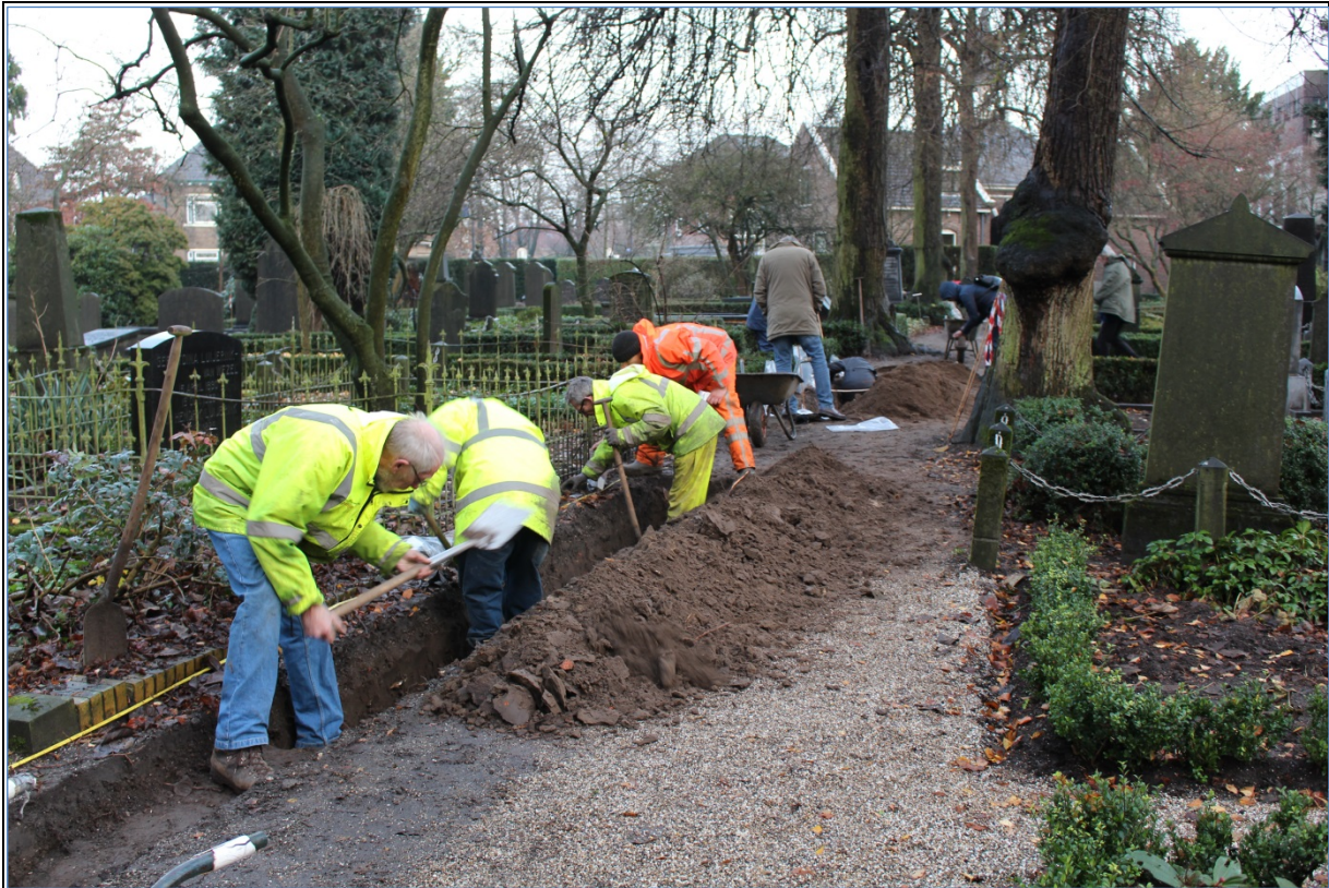
Rij aan rij aan het graven onder het middenpad, het échte handwerk. Foto: Nina van den Berg.
