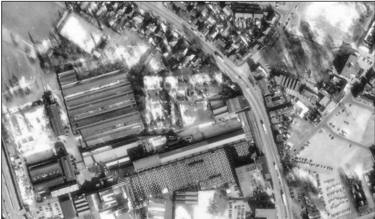
Afbeelding 3.13. Luchtfoto genomen op 7 februari 1986. Centraal de begraafplaats aan de Bornsestraat, met aan de west- en zuidzijde nog de gebouwen van het Heemaf-complex. Bron: Kadaster.
