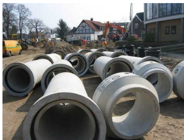
afbeelding 8: Rioolverzwaring Troelstrastraat
