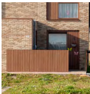
schuurtje in kleur metselwerk
