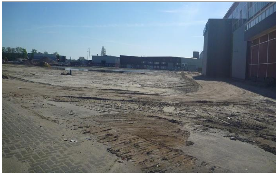
Figuur 8. Deelgebied Berflo Es Noord ter hoogte van de gesloopte bedrijfspanden, gezien in zuidwestelijke richting vanaf boring 28.
