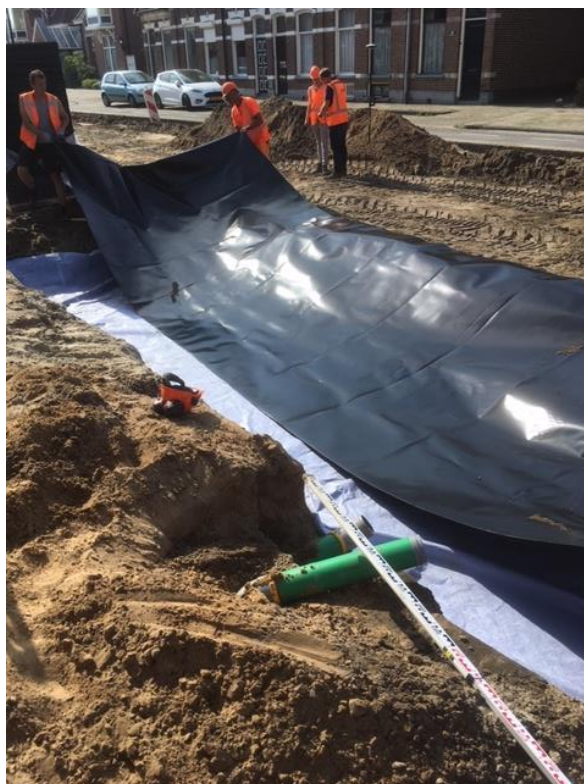
Figuur 1: Aanleg waterberging bij riolreconstructiewerkzaamheden Deldenstraat
