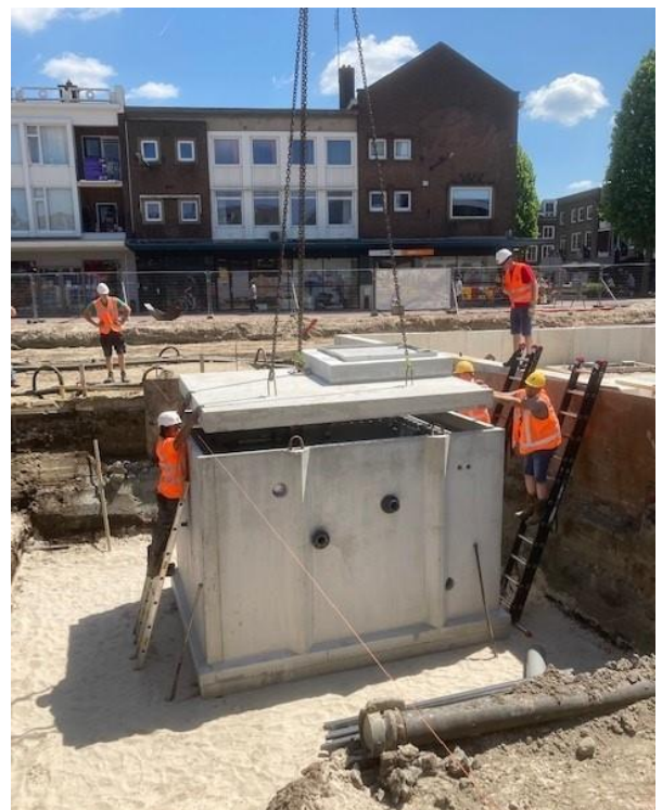
Figuur 9: Aanleg ondergrondse voorzieningen Markt/Brikstraat
