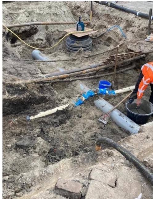
Figuur 7: Uitvoering rioleringswerkzaamheden
