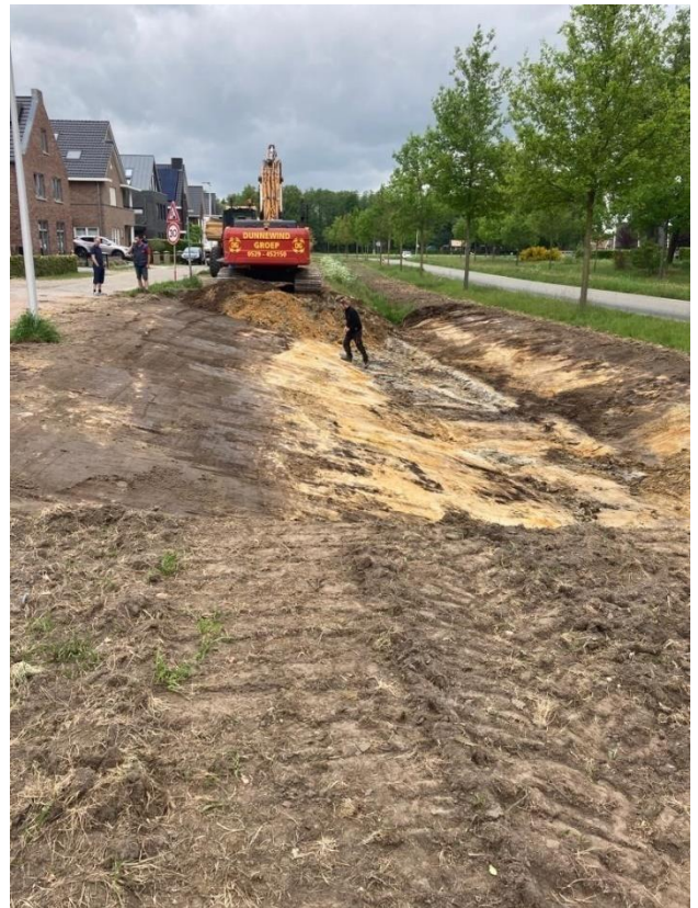
Figuur 14: Aanleg bovengrondse watervoorziening
