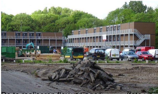
De te realiseren flexwoningen (foto uit delft) De potentiële bouwlocatie
